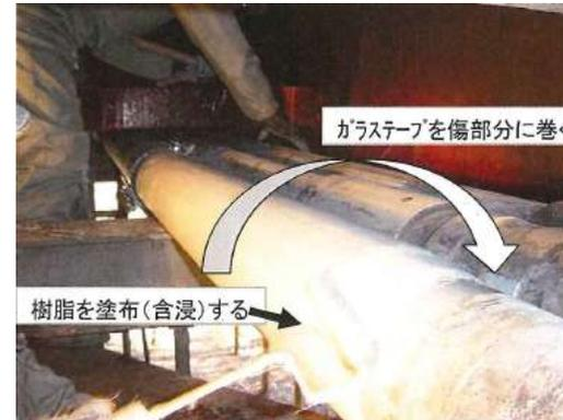
①損傷部に上記のガラステープを螺旋状に巻き付け、ローラーにて樹脂を含浸させます。
