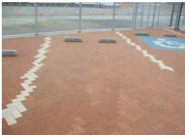
舗装コンクリートブロック
