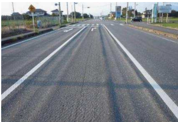
舗装表面の「見える」損傷
