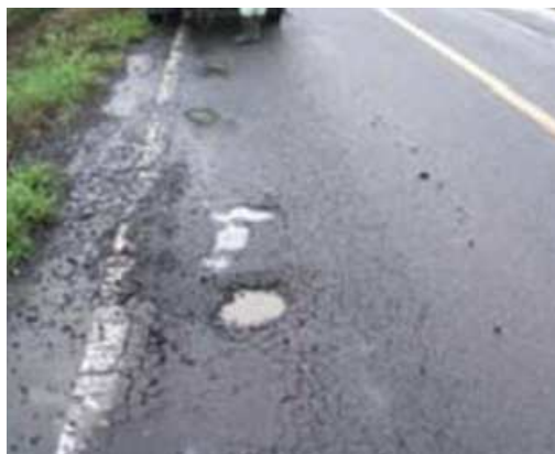
舗装表面の「見える」損傷
