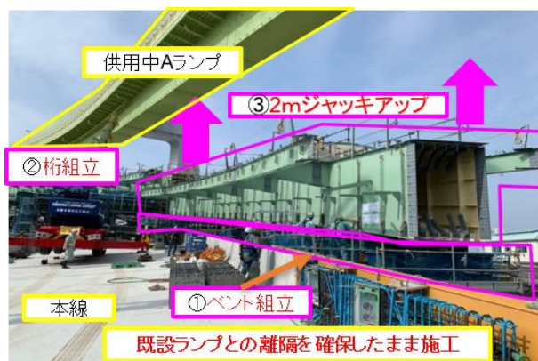
図-17 縦取り架設 施工手順
