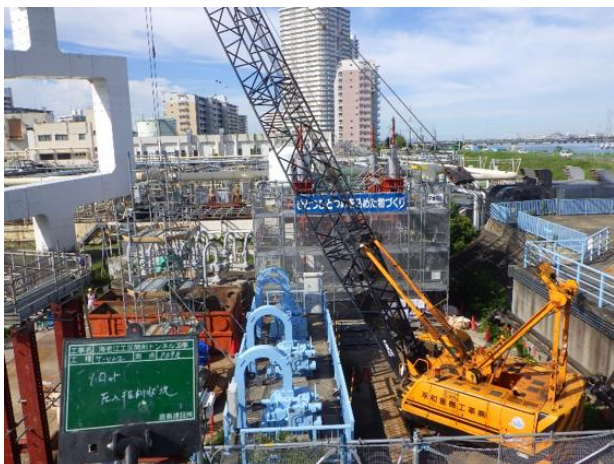
図-13 狭隘箇所でのケーソン圧入掘削状況
