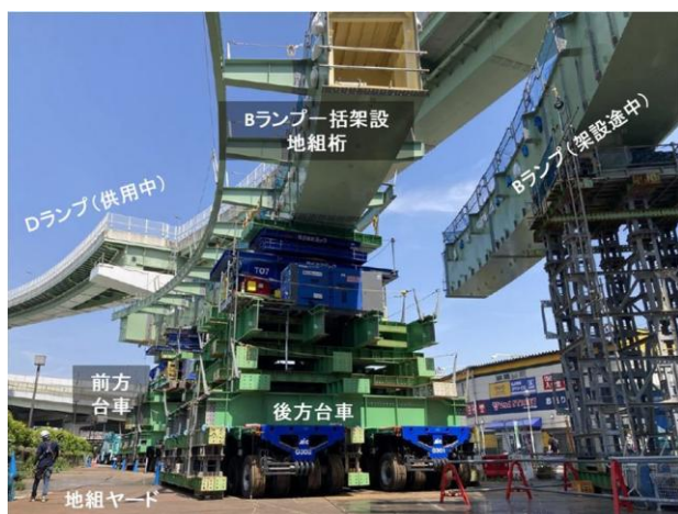
図-24 多軸台車上での桁地組状況
