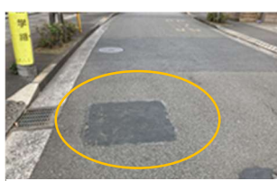
写真-1 路面補強工法の外観と補修キット
