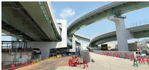
図-7 ラケット型及び逆 L 型鋼製橋脚
