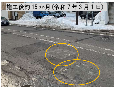
写真-10 補強後約15か月の路面状況
