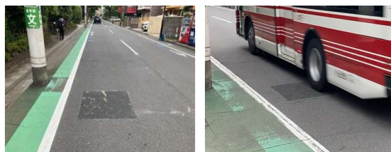
a) 試験施工箇所
