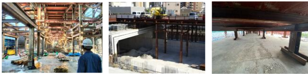
写真-1 仮栈橋の状況
