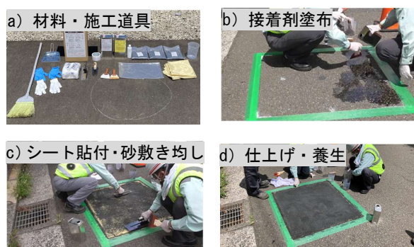
写真-2 施工状況
