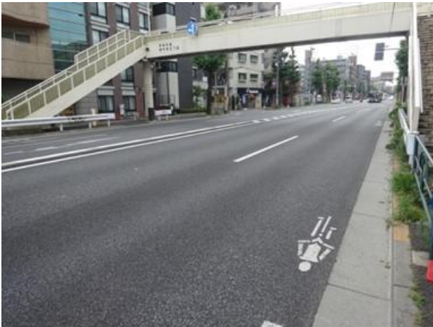
写真―1 中温化混合物（新材）施工完了後 （青梅街道）
