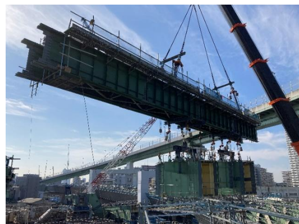
図-22 工事桁と主桁の吊下げ架設状況
