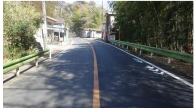
写真―3 中温化混合物（再生材）施工完了後 （陣馬街道）
