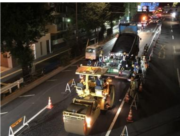
写真―2 中温化混合物（新材）施工中の状況 （青梅街道）
