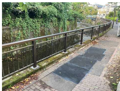
写真－12 補強直後の路面状況
