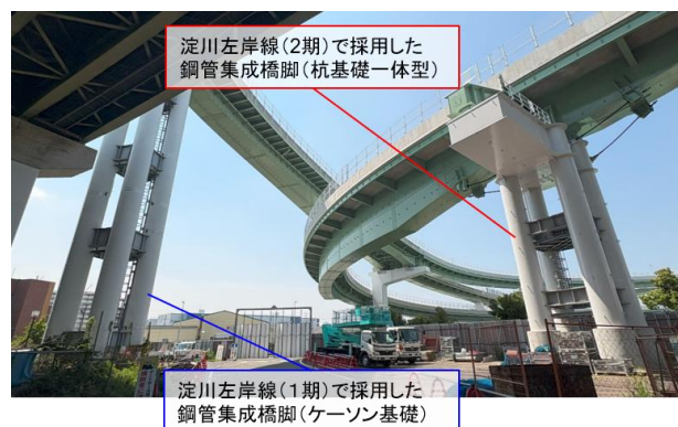
図-9 鋼管集成橋脚（現地写真）
