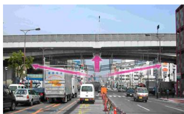
ケーブルによる補強状況
