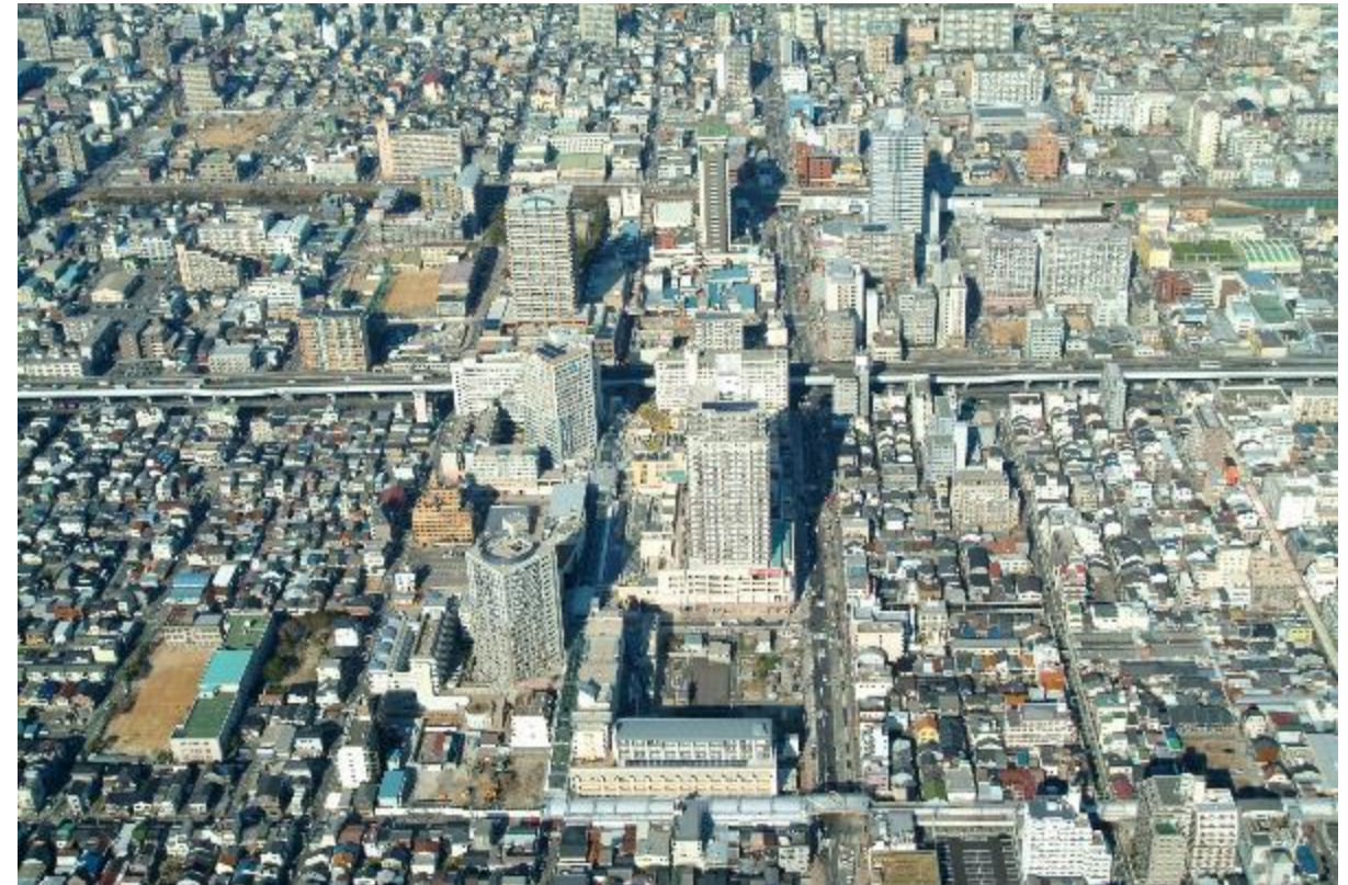
震災発生10年後 平成17年（2005年）1月
