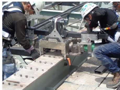
写真-3 スタッドの切断状況
