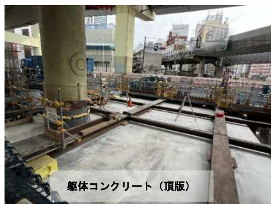
写真-8 躯体コンクリート完成状況(頂版)
