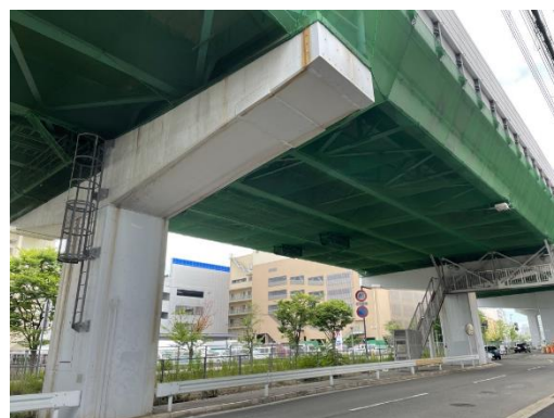
写真-2 現地状況（取替前）
