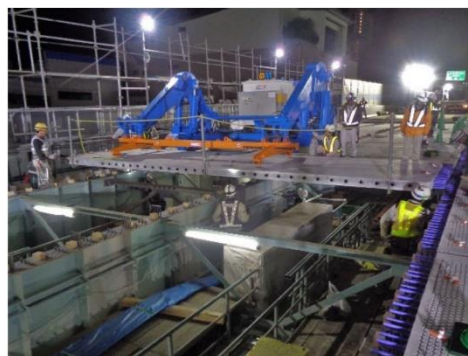
写真-4 床版の設置状況
