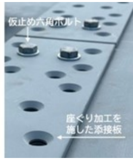
写真－6 皿型高力トルシアボルト (左)
