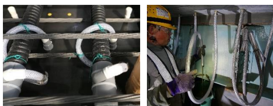
写真-6 下面具ラウド治具と作業状況
