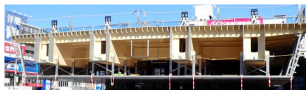
写真－4 鋼製箱桁の断面
