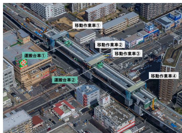
写真－3 PC 箱桁撤去時の状況
