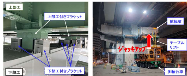
図-6 水平力分担構造 写真-3 鋼製梁の拡幅
