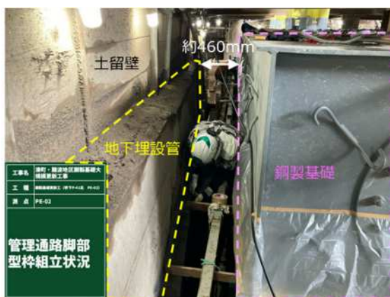
写真-6 躯体コンクリート型枠組立状況
