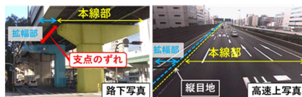
写真-1 本線部と拡幅部
