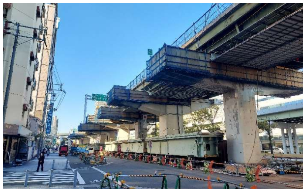
写真-8 撤去した既設拡幅桁
