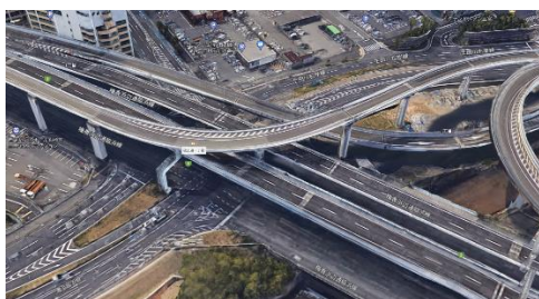
写真-7 現地状況（取替前）
