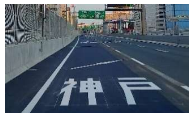
写真-6 工事完了後
