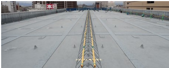
写真－8 鋼床版上の添接板接合部
