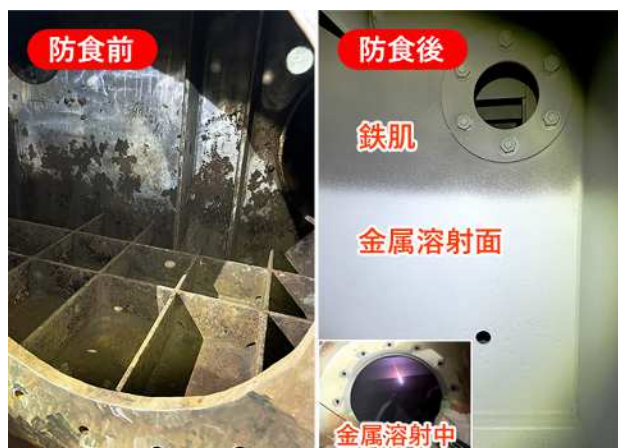
写真-5 鋼製基礎内面の防食前後の状況
