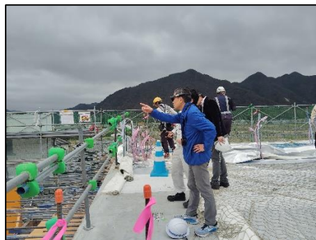
型枠完成場所で配筋後のVR体験
