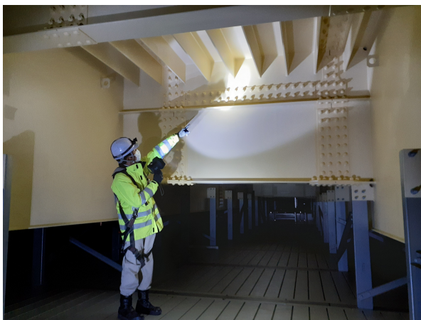
写真－10 常設足場 (内部)
