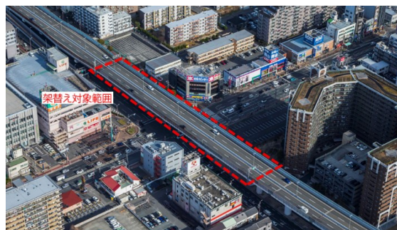
写真－2 喜連瓜破橋と周辺状況
