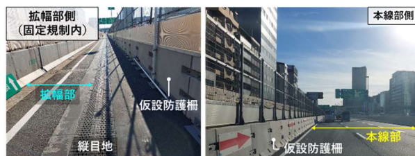
写真-6 高速上固定規制の設置状況
