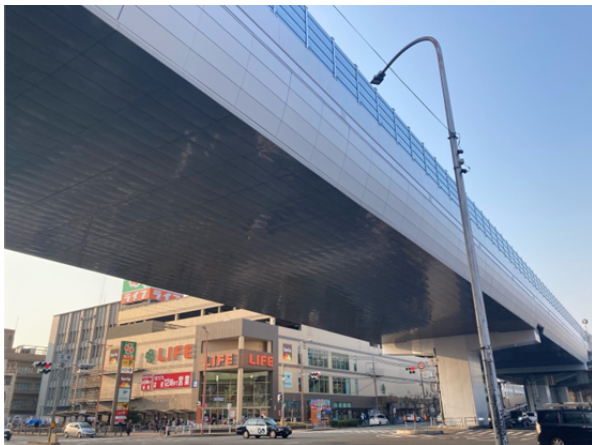
写真－9 常設足場 (外観)
