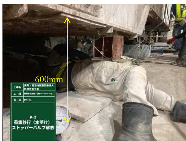
写真-4 鋼製基礎下面での作業状況
