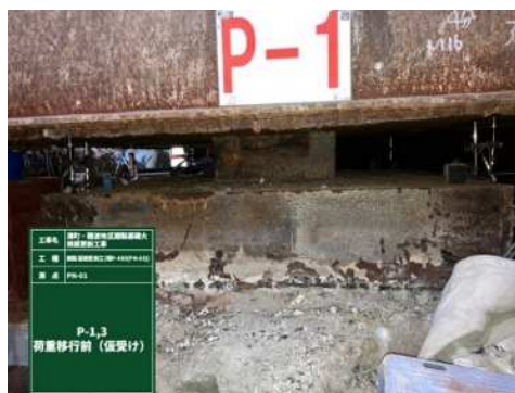
写真-2 支承取替え前の状況
