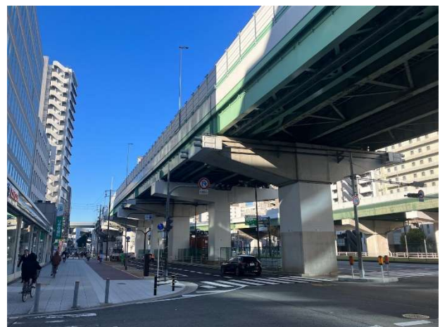
写真-5 改築後の下部工
