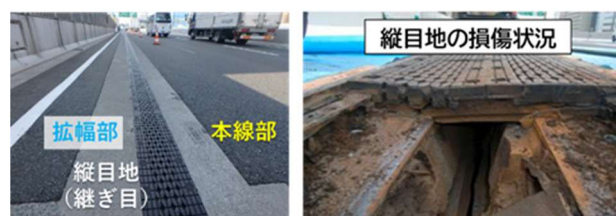
写真-2 縦目地構造
