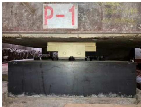
写真-3 支障取替え後の状況
