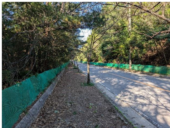
写真-3 侵入防止ネット (国頭村)
