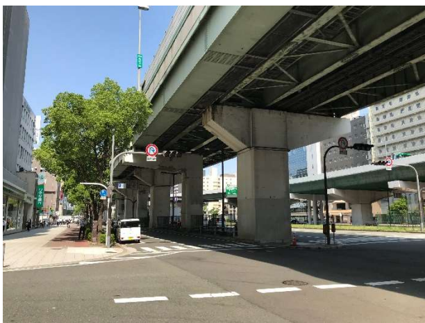
写真-4 改築前の下部工
