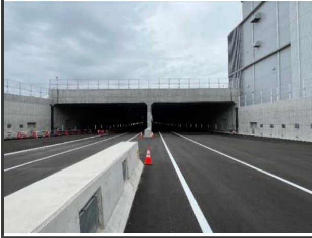
下流側坑口部 (TN完成部)
