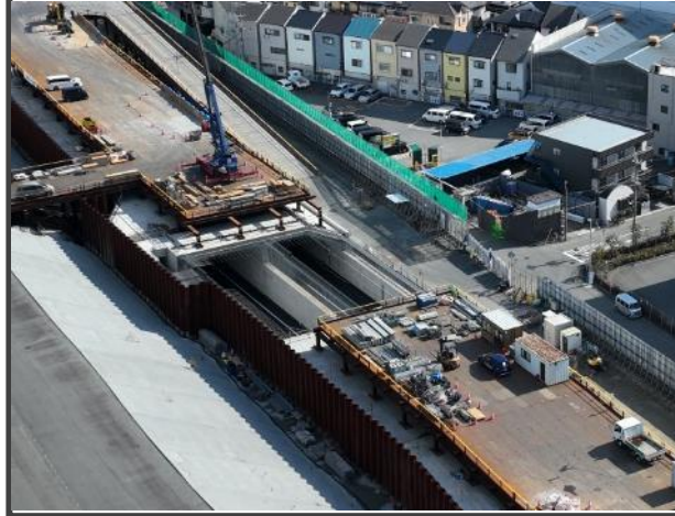
国道2号～JR神戸線 (TN一部完成部)
