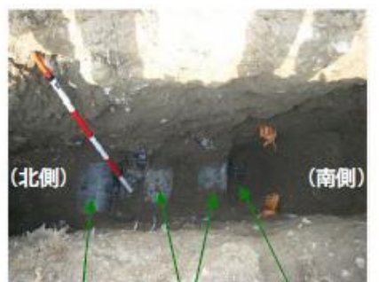
地下埋設物の試掘状況
