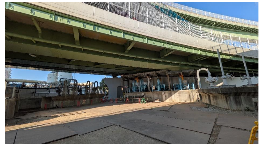
既設設備に干渉しない詳細設計・施工を実現
