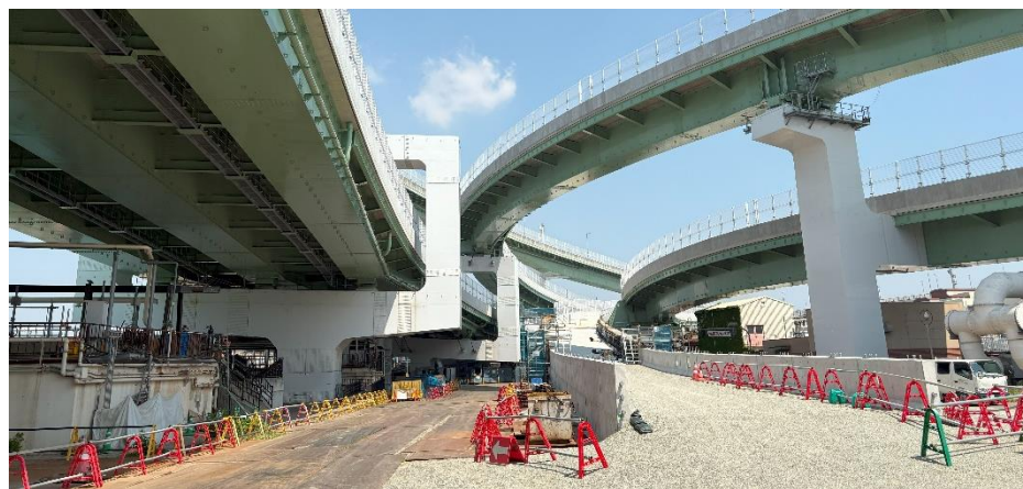
複数の橋桁を受け持つ様々な形状の鋼製橋脚を採用
