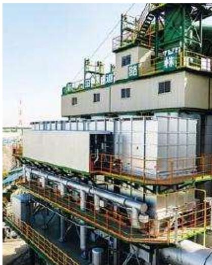
脱臭炉は骨材の乾燥・加熱時発生する臭いの排出を軽減する装置で、燃焼室内のハニカムセラミックス蓄熱体によって燃料消費量やCO<sub>2</sub>発生量を抑制しながら悪臭を800℃で分解・無害化する。
