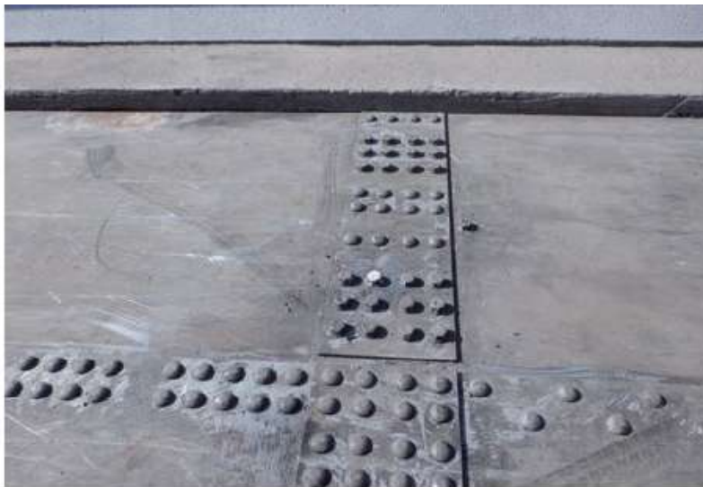
鋼床版上のボルト部
