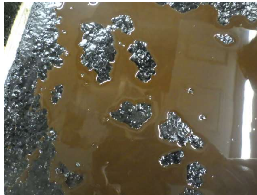
乳剤塗布時の状況（過年度試験時）
