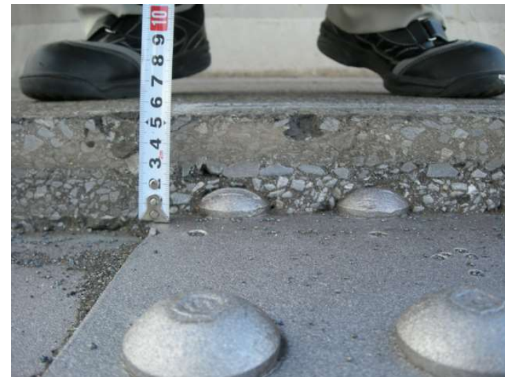
ボルト部舗装断面
