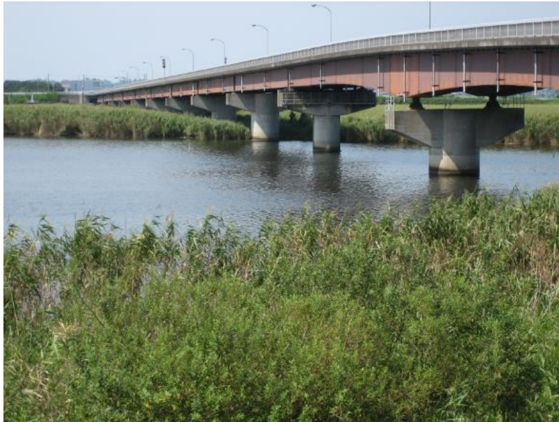
多径間連続の渡河橋
