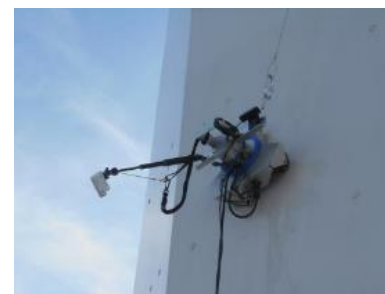
壁面移動ロボットによる主塔の画像計測
