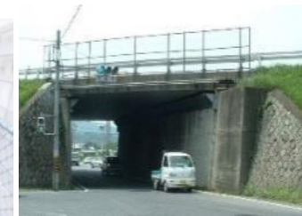
RC床版橋の主版
