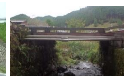
H形鋼橋の主桁・横桁
