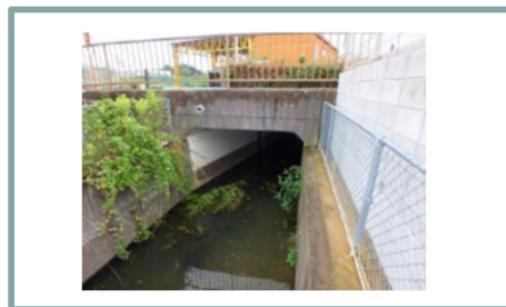
■ 溝橋(ボックスカルバート)
