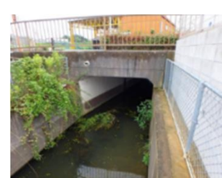
ボックス形式の溝橋
