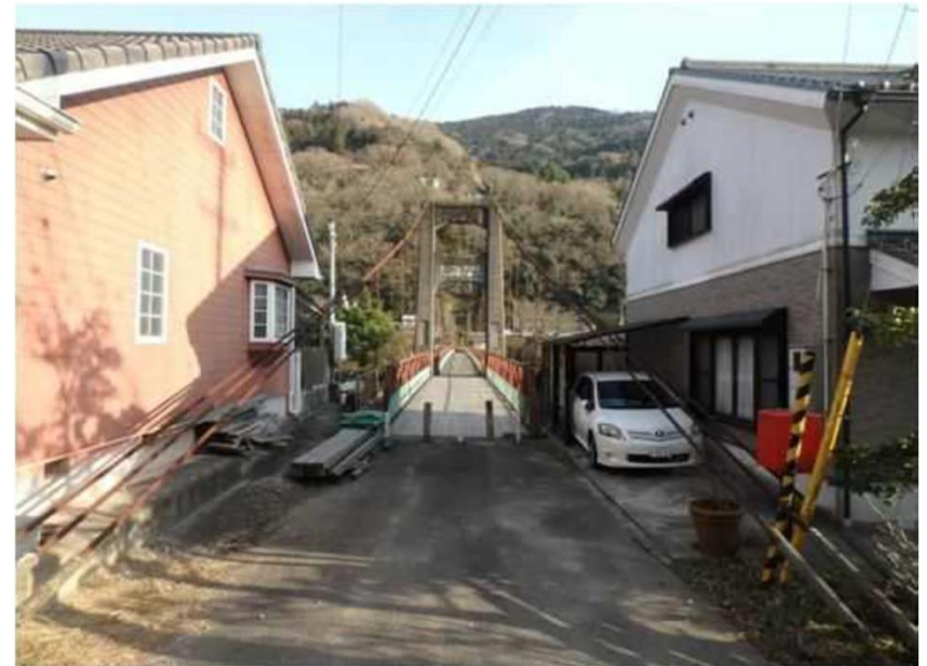
点検車や高所作業車が乗れない吊り橋
