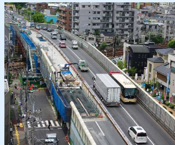
床版の取替(RC→鋼)
