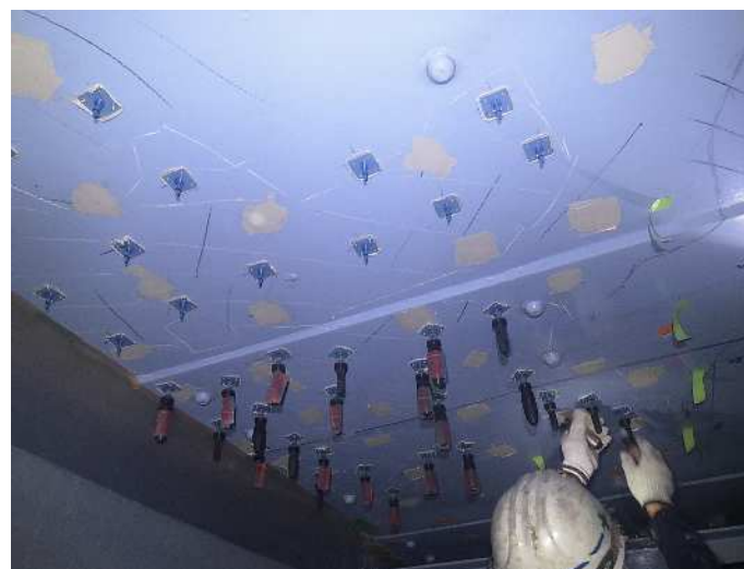
接着鋼板への再注入
