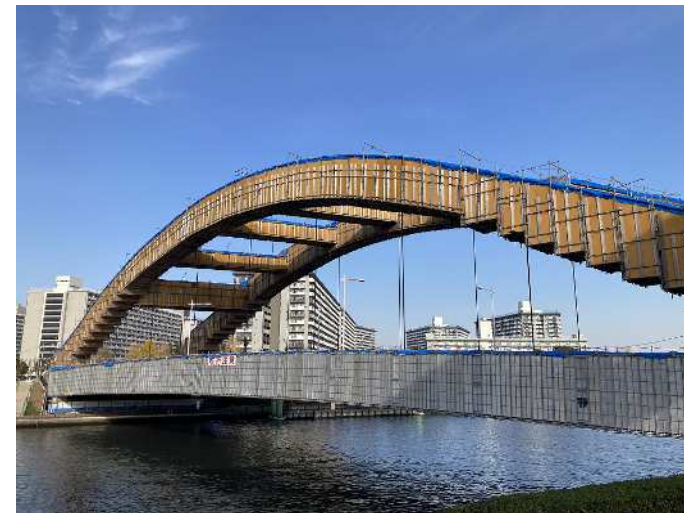
塗膜剥離剤による除去作業
