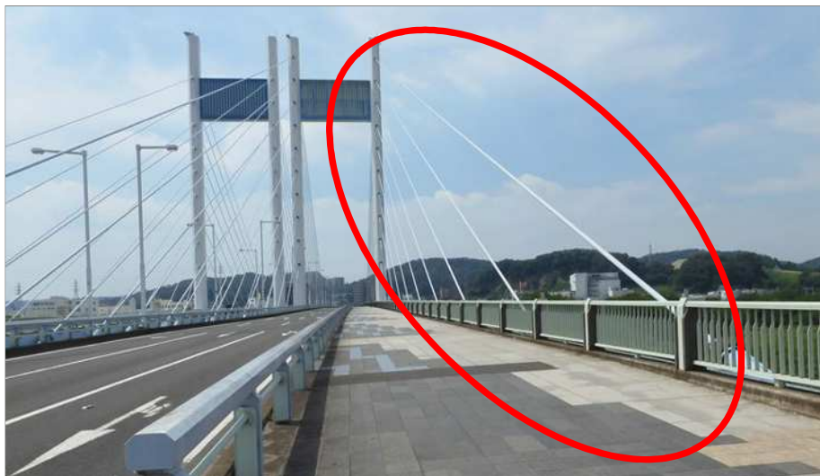
斜張橋のケーブル
