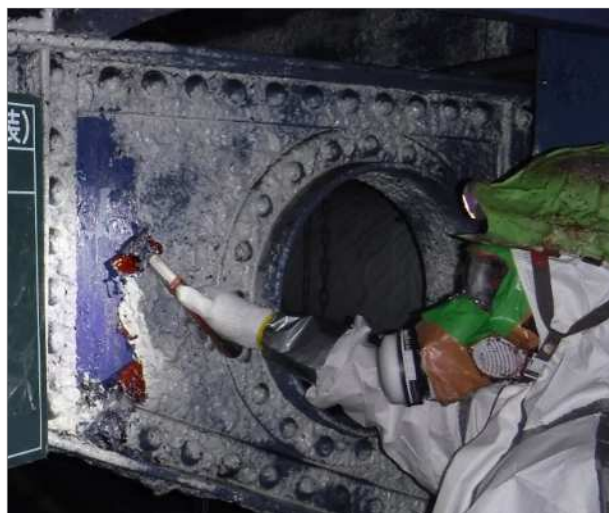
塗膜剥離剤による除去作業
