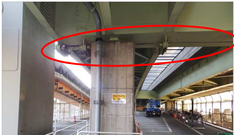
端横桁に挟まれた狭隘部
