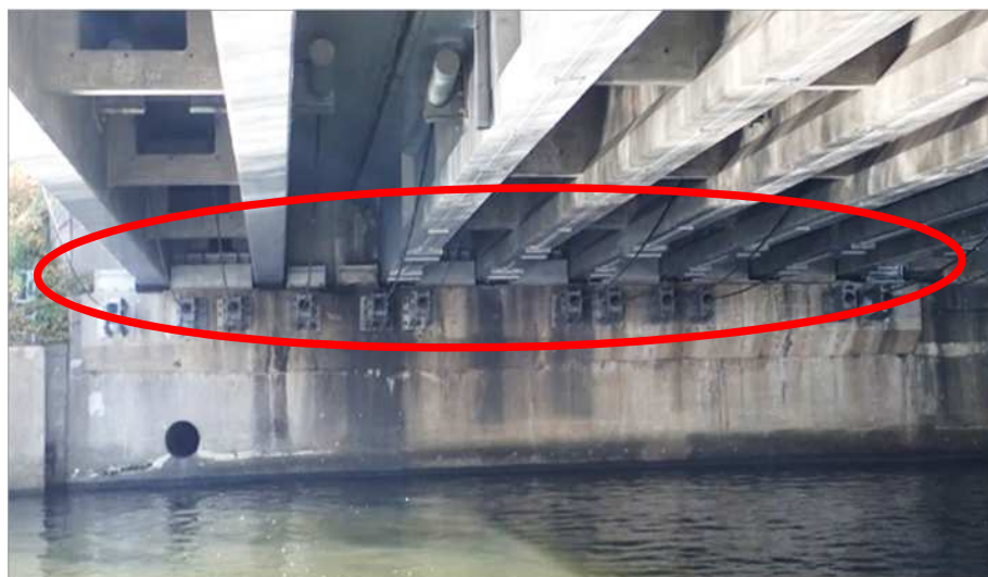
水面から高い位置にある橋座部
