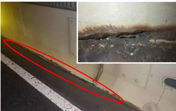
写真-7 鋼製地覆 地際部の孔食
