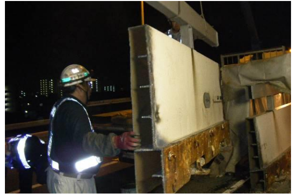
写真-16 過年度実施の鋼製高欄取替工事
