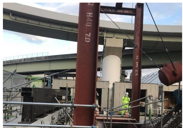
写真-15 重錘衝突試験による性能確認
