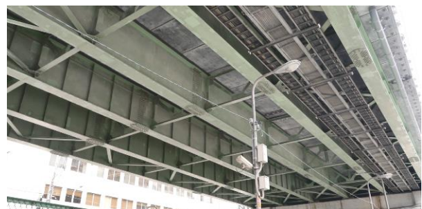
写真-10 完成後（路下より）
