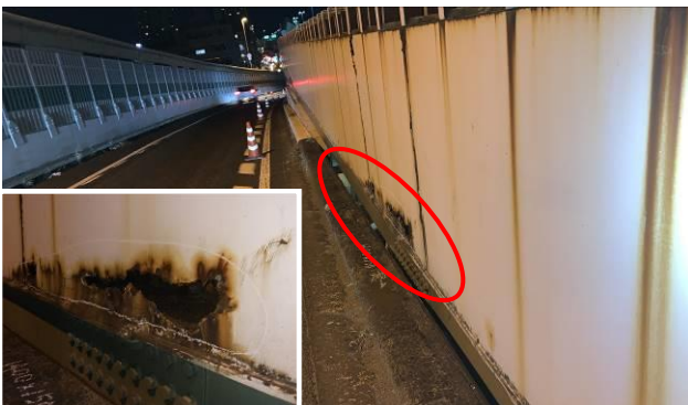
写真-7 鋼製地覆 地際部の孔食
