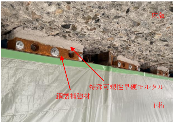
写真-1 仮補強材の設置状況
