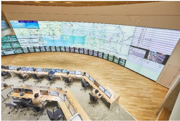
写真-1 新交通管制室（大阪地区）
