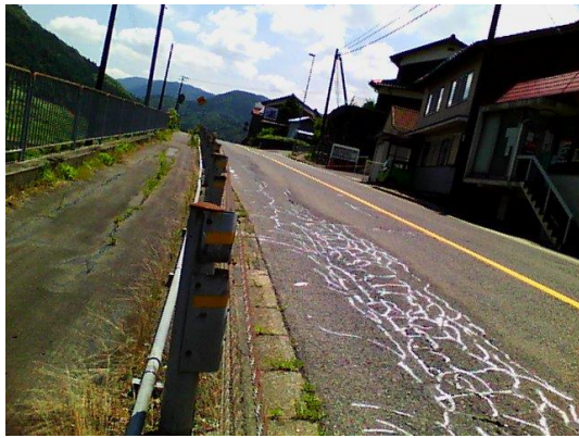
図-5 国道9号線路面状況
