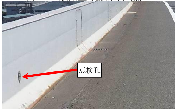
写真-2 (近年型)既設鋼製高欄
