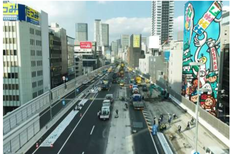
2021年度（北行）の工事状況
