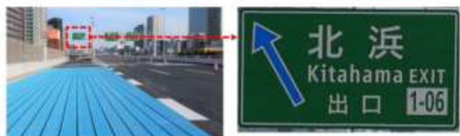
1号環状線(南行)リニューアル工事における案内標識および出口部のカラー舗装の施工例
