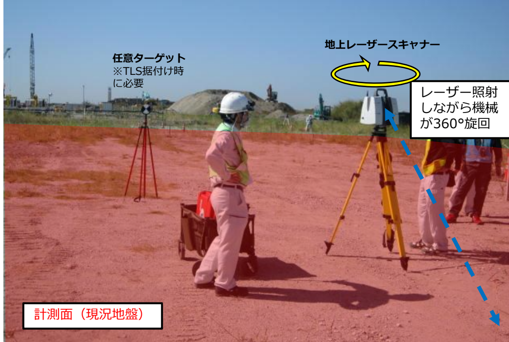
測量状況写真
