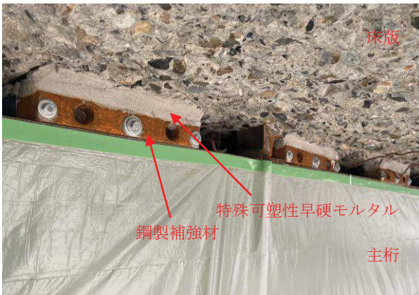
写真-1 仮補強材の設置状況
