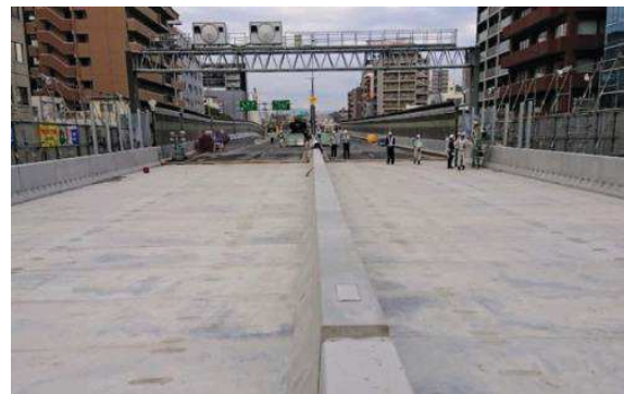
写真-9 床版・高欄中央分離帯設置完了
