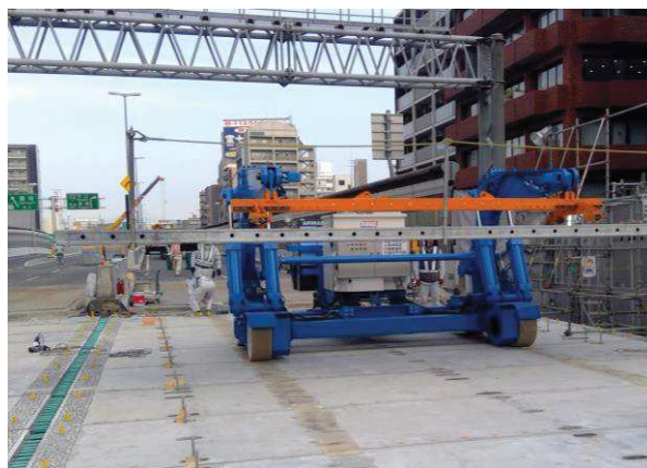
写真-7 専用架設機によるUFC床版の架設
