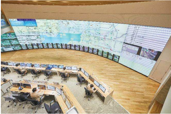
写真-1 新交通管制室（大阪地区）
