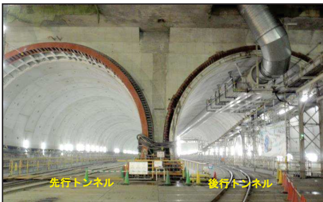
写真 - 3 シールド併設状況
