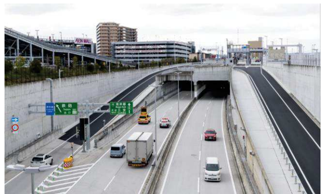
写真 - 2 全線開通
