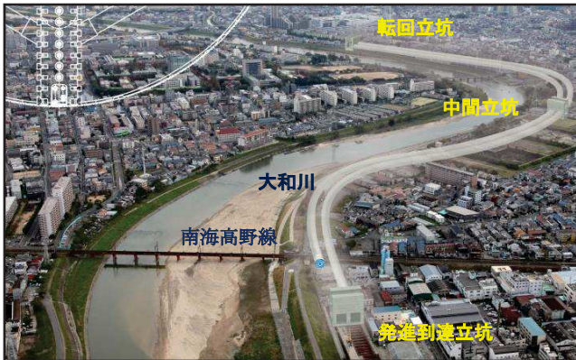
写真 - 2 シールド地上状況 (曲線線形)
