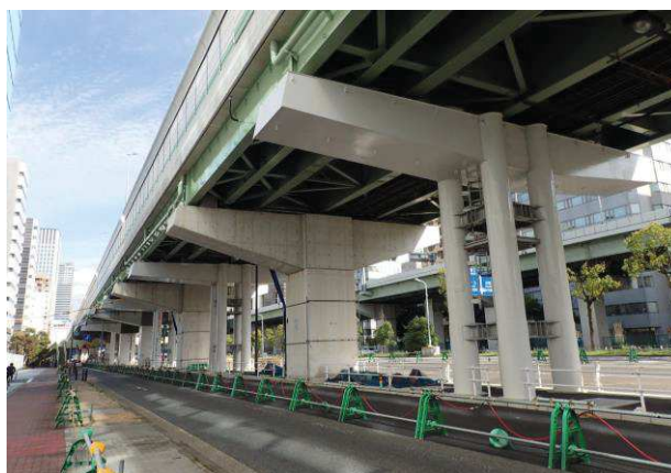
写真-4 完成後の鋼管集成橋脚
