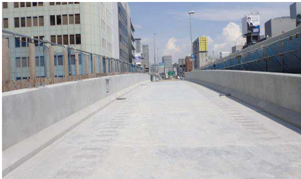
写真-7 UFC床版施工完了後の状況
