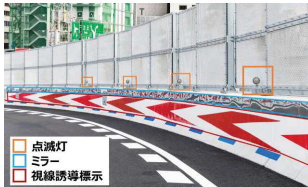
写真-8 信濃橋渡り線カーブ部の交通安全対策
