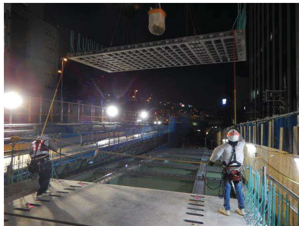
写真-6 UFC 床版パネルの架設
