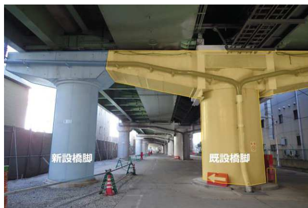
写真-3 環状線拡幅部の構造
