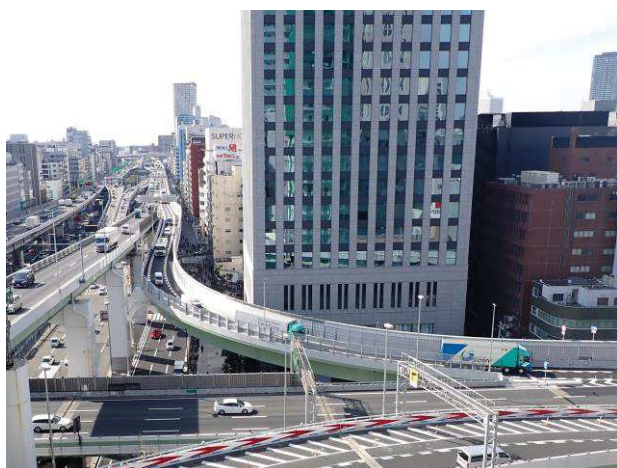
写真-1 開通後の信濃橋渡り線の様子
