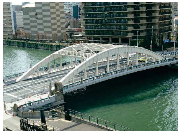
写真-5 完成写真
