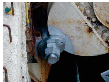
写真-1 支承ピン
