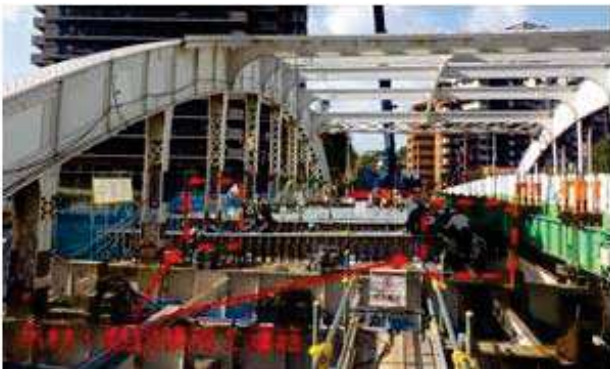
写真-3 鋼床版架設
