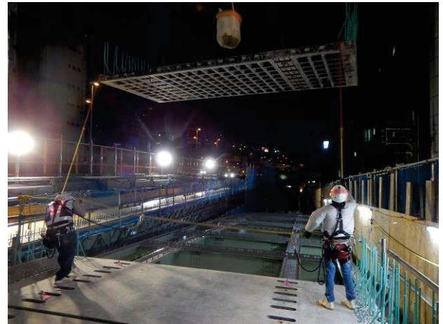
写真-6 UFC 床版パネルの架設
