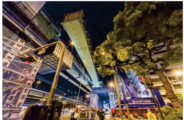
写真-5 四つ橋筋上空における鋼桁一括架設
