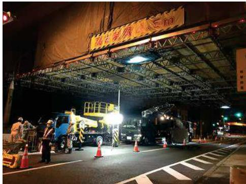
写真-4 ヒンジ部高流動コンクリート打設状況
