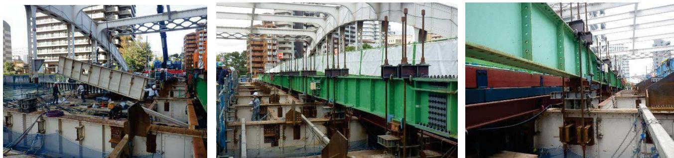
写真-2 既設横桁撤去状況・工事桁配置状況・横桁吊り設備
