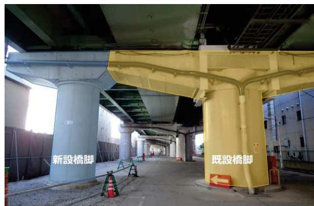
写真-3 環状線拡幅部の構造
