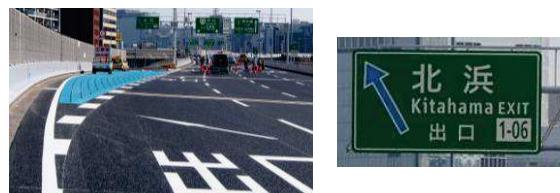
写真-4 出口カラー舗装 (北浜出口)
