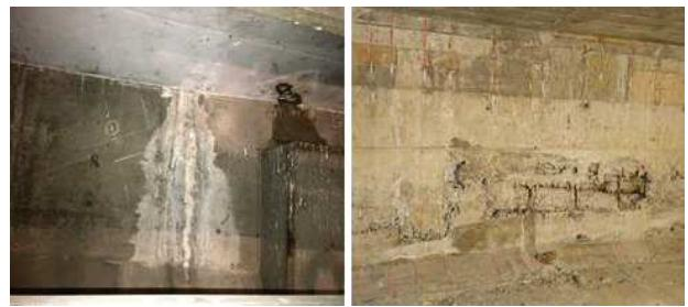
写真-3 箱桁の漏水（遊離石灰）、充填不良
