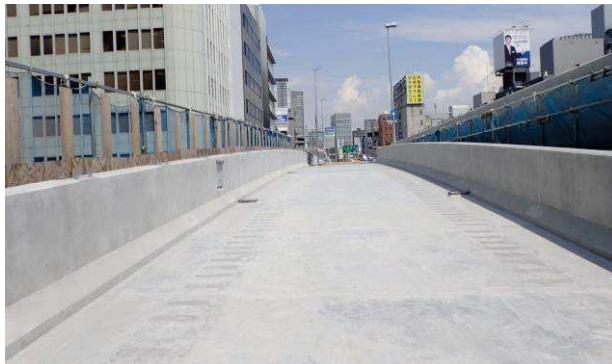
写真-7 UFC床版施工完了後の状況
