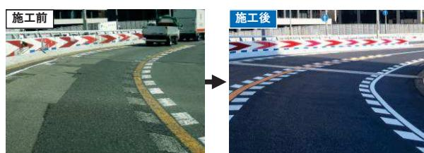
写真-1 舗装、伸縮継手の補修
