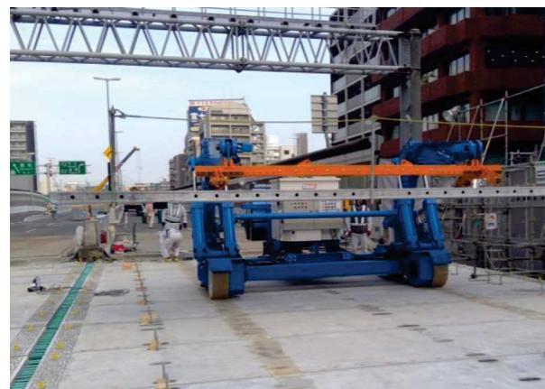
写真-7 専用架設機によるUFC床版の架設
