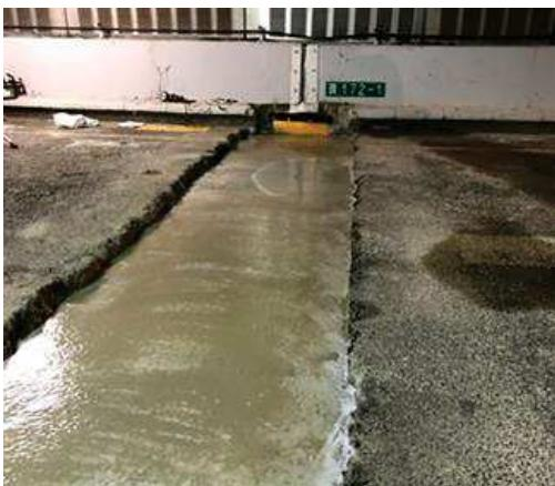
写真-8 上床版コンクリート打設直後
