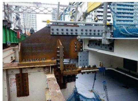
写真-4 既設横桁連結治具
