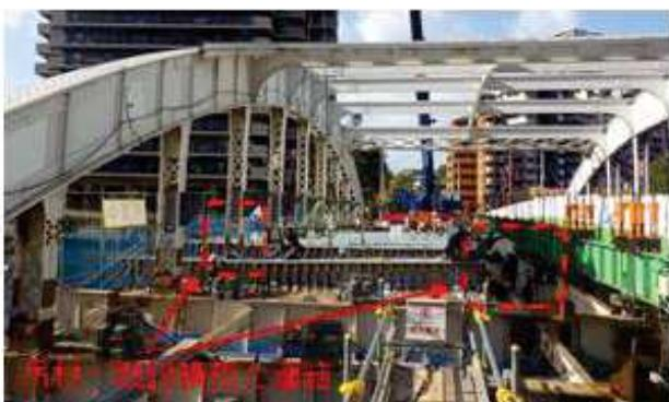
写真-3 鋼床版架設
