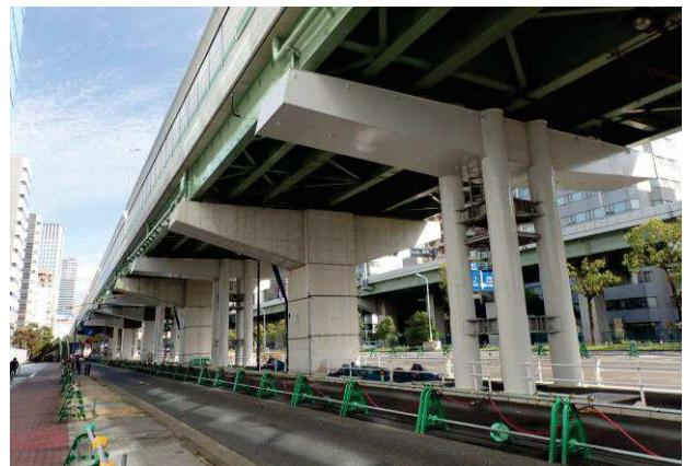
写真-4 完成後の钢管集成橋脚
