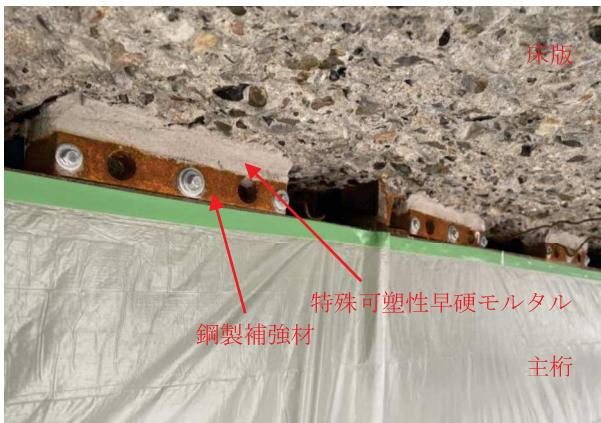
写真-1 仮補強材の設置状況
