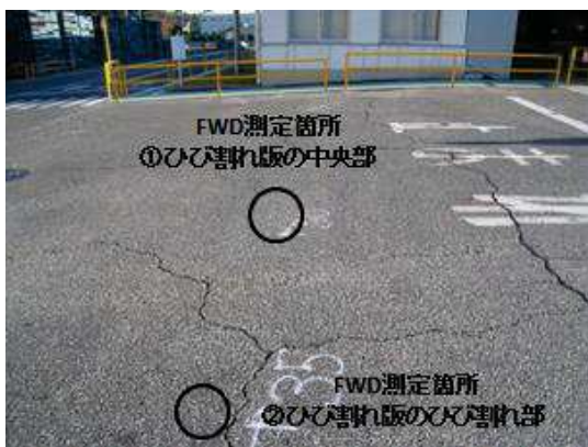
写真-5 FWD 測定箇所 (1)
