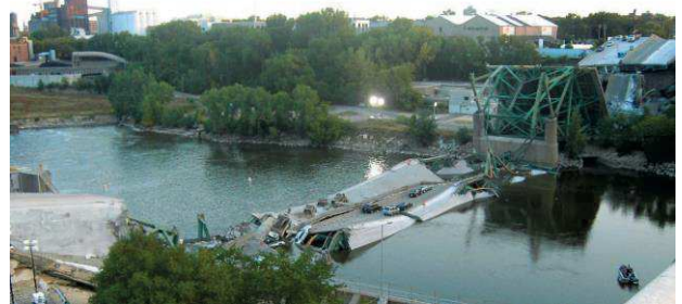
写真-4 ミネアポリス市における落橋状況
