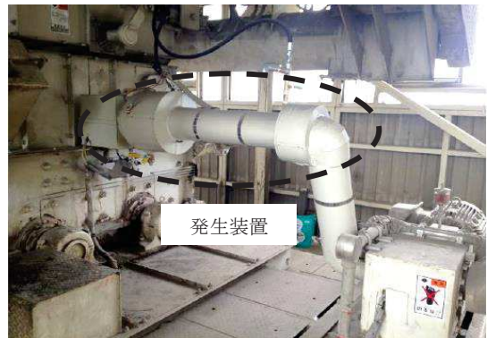
写真-1 FAs 装置の外観
