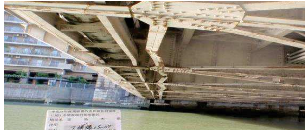
写真-3 床組の損傷状況（変形）
