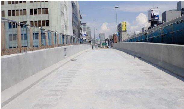
写真-7 UFC床版施工完了後の状況
