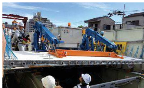
図-7 UFC床版の施工状況
