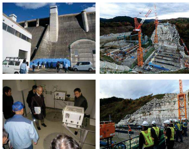
比奈知ダム（三重県名張市）および川上ダム (R1.11.29)
