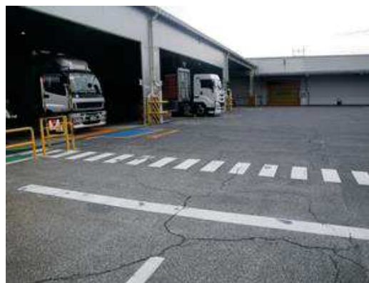
写真-4 施工前状況
