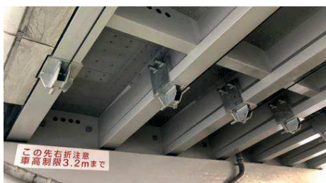
図-5 PC桁の外ケーブル補強
