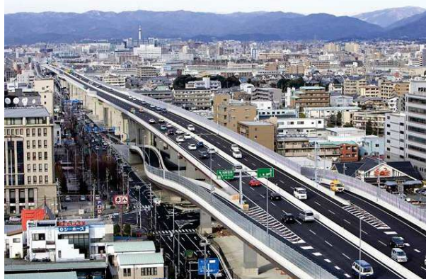
写真-1 京都高速道路(第二京阪道路)
