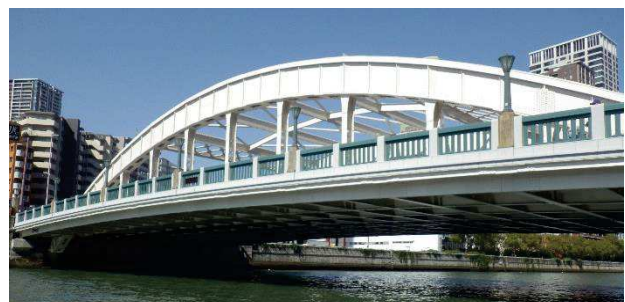
写真-4 工事前後の堂島大橋全景 （上：着工前、下：完成後）
