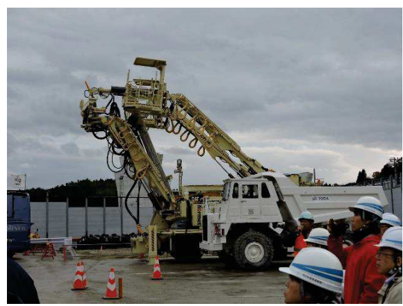
コンクリート吹き付け機
