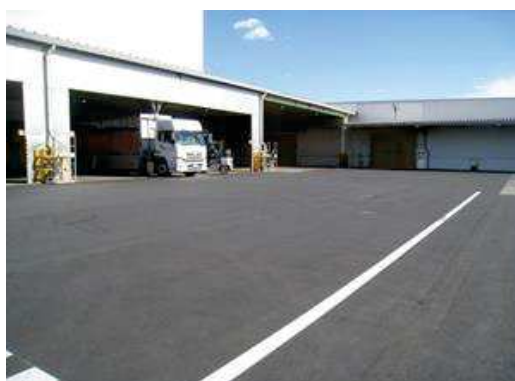
写真-7 施工後 2 年 1 ヶ月後状況
