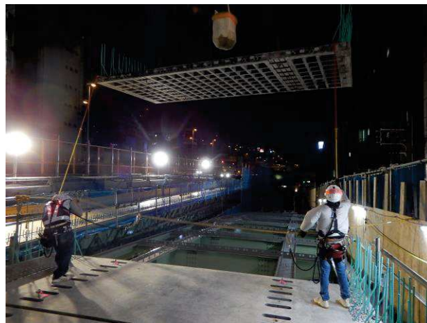
写真-6 UFC 床版パネルの架設
