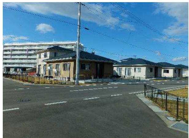
写真-2 閑上地区の戸建て住宅と復興住宅
