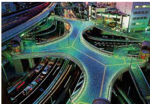
写真－4 大小路歩道橋の架替え
