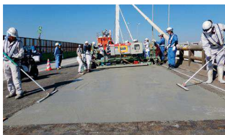
図-6 SFRC舗装の施工
