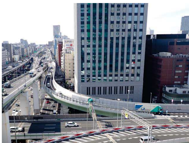
写真-1 開通後の信濃橋渡り線の様子
