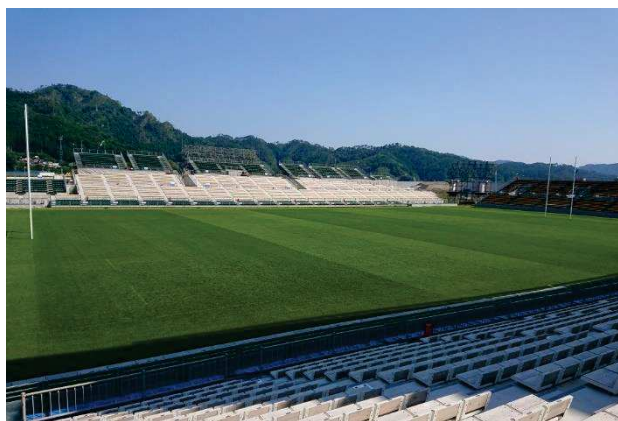
写真-8 釜石鶉住居復興スタジアム
