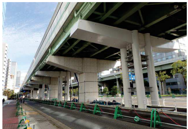
写真-4 完成後の鋼管集成橋脚
