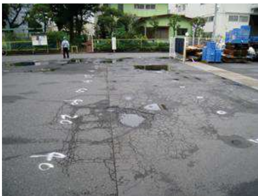
写真-2 施工前損傷状況
