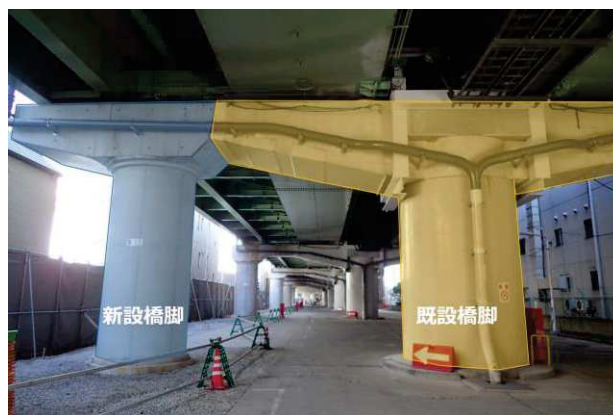
写真-3 環状線拡幅部の構造
