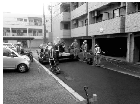
写真-8 データ取得（道路建設現場）
