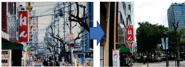
写真－3 電線類の地中化
