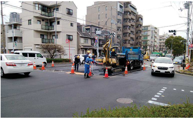
写真-2 施工割により生じる臨時の交通規制を伴う為、関係する全ての条件が考慮される。
