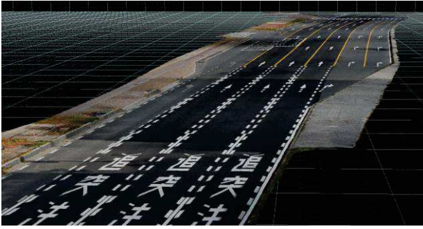
図-5 高密度3次元計測データ(写真-5の現場)
