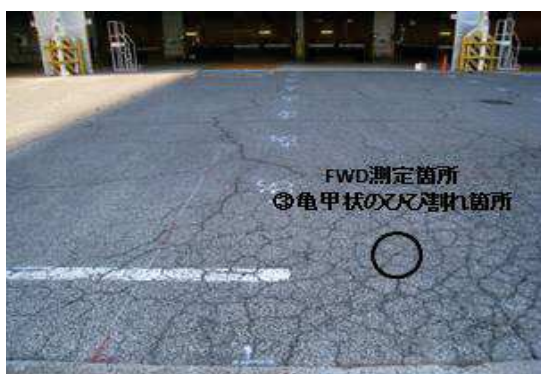
写真-6 FWD 測定箇所
