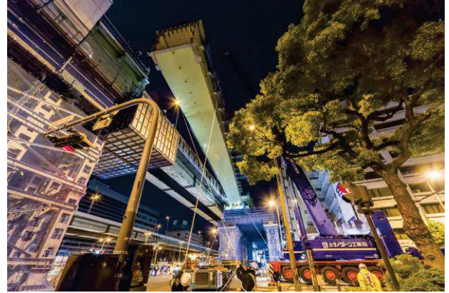
写真-5 四つ橋筋上空における鋼桁一括架設
