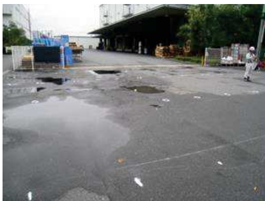
写真-1 施工前状況
