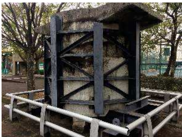
写真-1 被災した橋脚(須磨海浜公園) 県道神戸明石線 西代跨線橋
