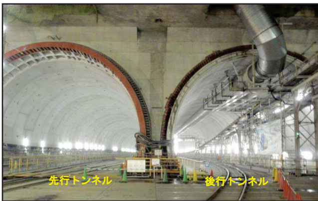
写真 - 3 シールド併設状況
