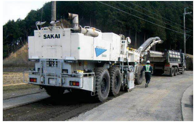
写真-6 路面切削機を転用した整正状況
