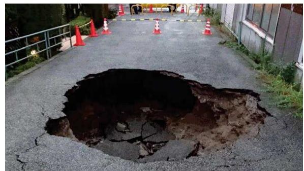
写真-1 道路陥没状況
