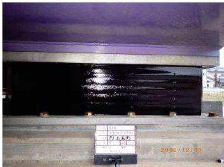
図-13 K-PRO工法の仕上がり状況
