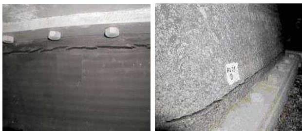
図-5 ゴム支承表面のき裂発生状況
