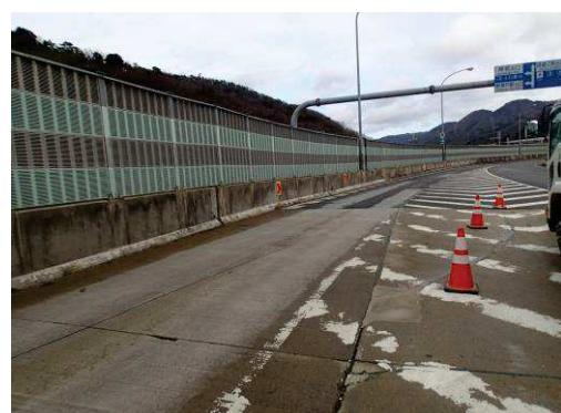
写真-1 料金所内コンクリート路面状況
