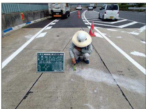
写真-2 空隙測定状況
