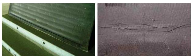
図-7 ゴム支承表面のき裂発生状況
