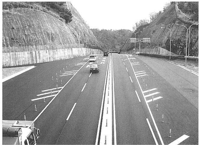
料金所跡 再整備後
