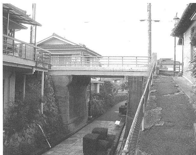
写真7 道路の下の道路（橋は大正13年完成です）
