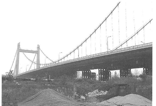
写真11 慶豊橋全景（施工中）
