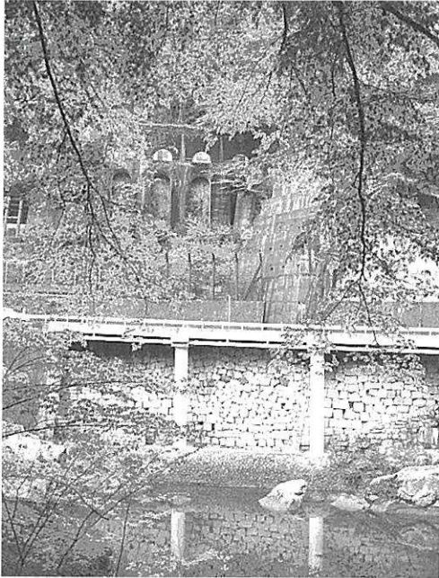
写真3 木曾の棧の名残（石垣部分） 上部の構造物はJR中央本線です
