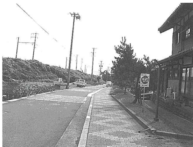
写真6 ハンプのある道路（関ヶ原付近）
