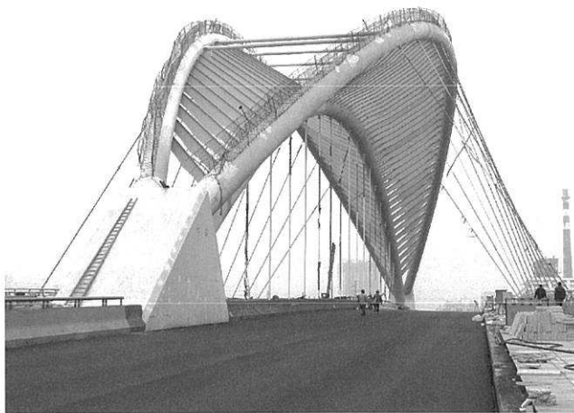
写真13 長豊橋(施工中)
