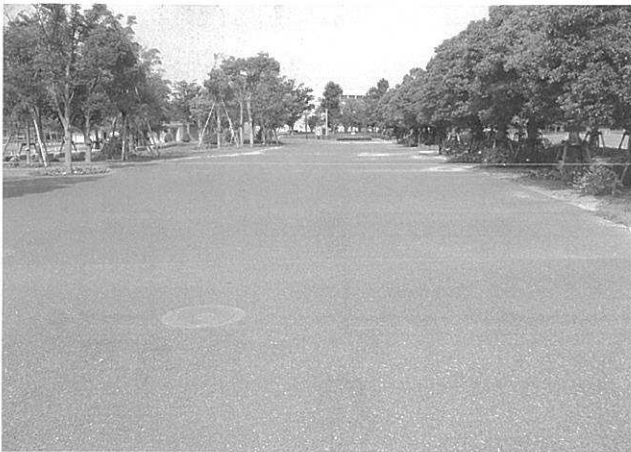
写真6 供用後4年経過した保水性舗装と舗装表面の状況（浜名湖花博会場）
