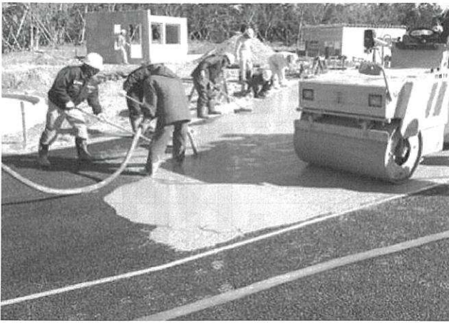
写真4 保水材の充填状況
