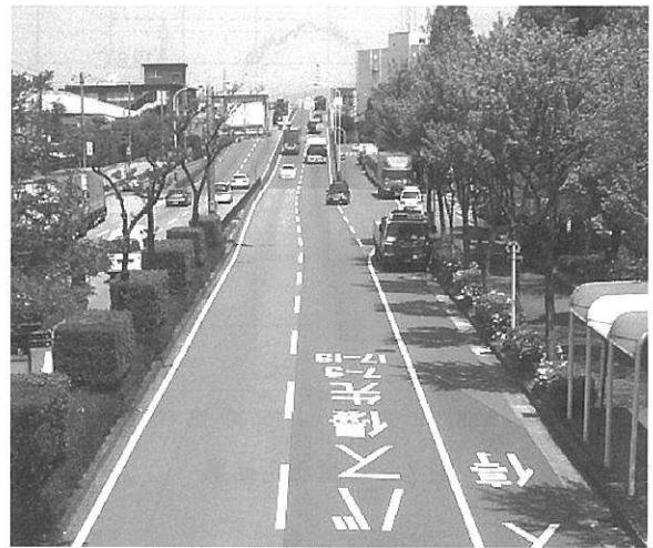
写真1 (主) 尼崎池田線の現場写真（完成時）
