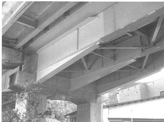
写真-4.1 上下部構造剛結部
