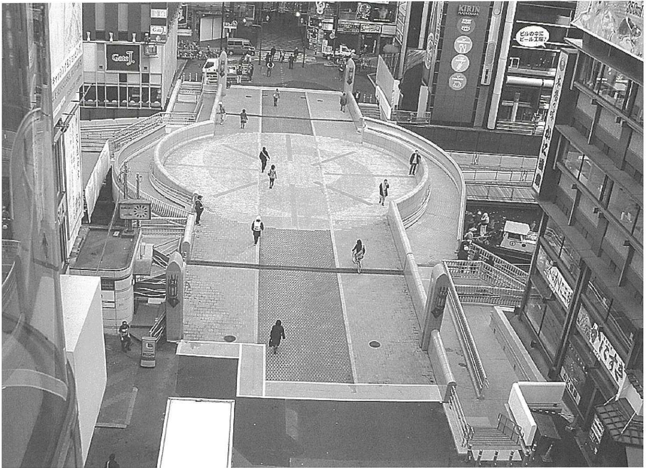
写真-10 新たな戎橋（平成19年11月現在）
