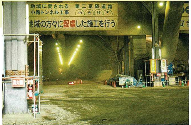
小路トンネル
