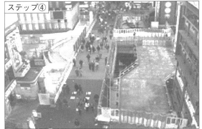
写真-5 桁架設Ⅰ期完了(西側)
