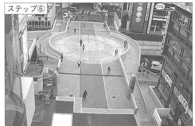
写真-7 完成(橋梁部)
