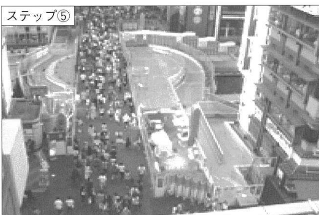
写真-6 桁架設Ⅱ期完了(東側)
