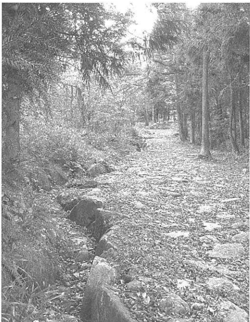
写真6 十三峠の石畳(復元)側溝が完備されています。
