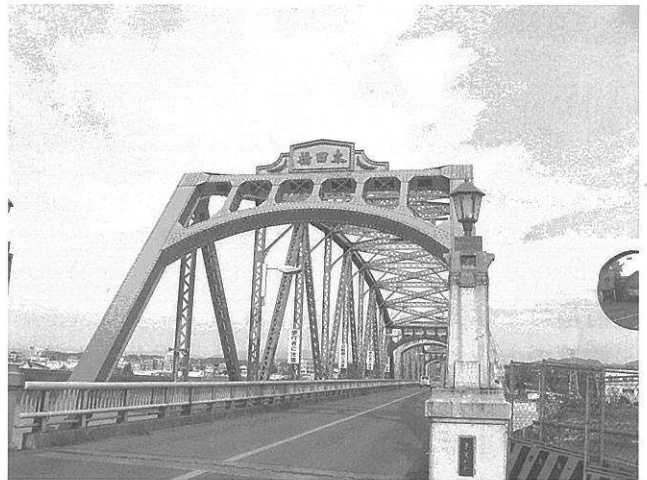
写真7 太田橋橋門、大正末期に完成した美しい橋です。現在上流側に橋側歩道橋が工事中です。
