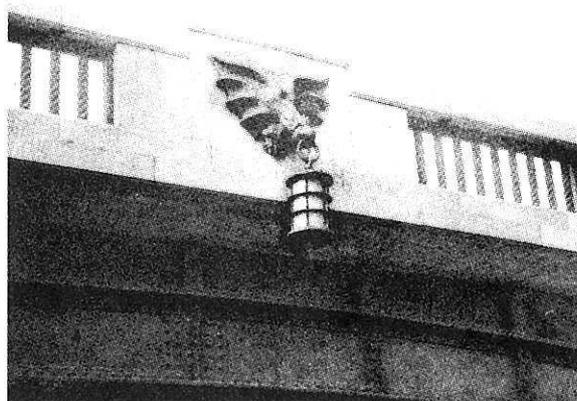
写真25 旧渡辺橋・肥後橋の航路標識灯\*
