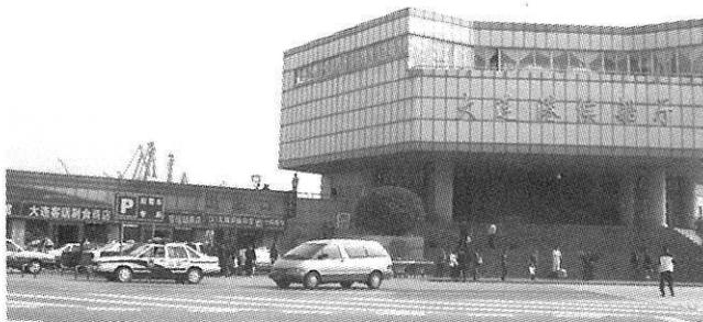
写真14 大連港の船客待合室(1925年完成)は、2階レベルのブリッジと1階レベルの満鉄線ホームで上下船の旅客動線を立体分離。
