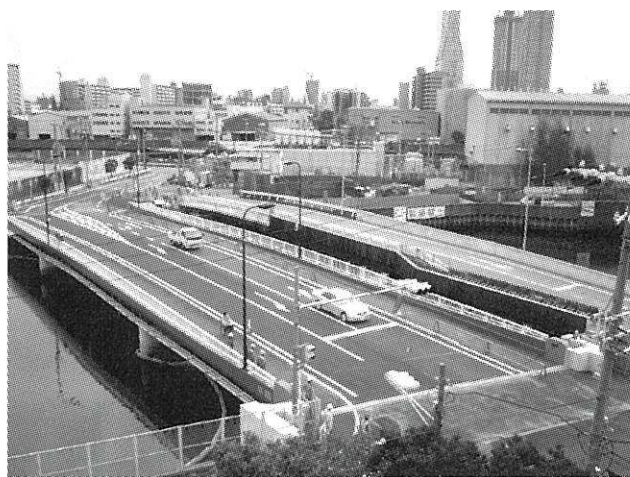
写真—3 完成した春日出橋
