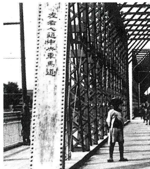
写真15 歩車道分離の表示
