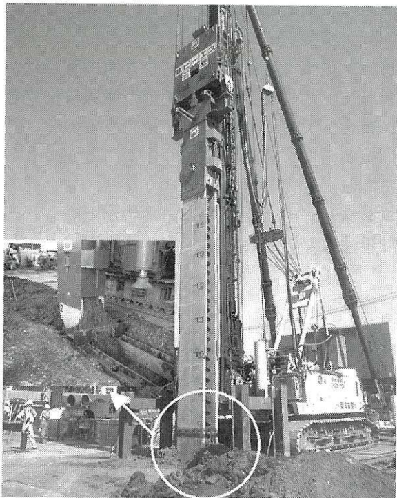
写真-5 掘削・圧入状況
