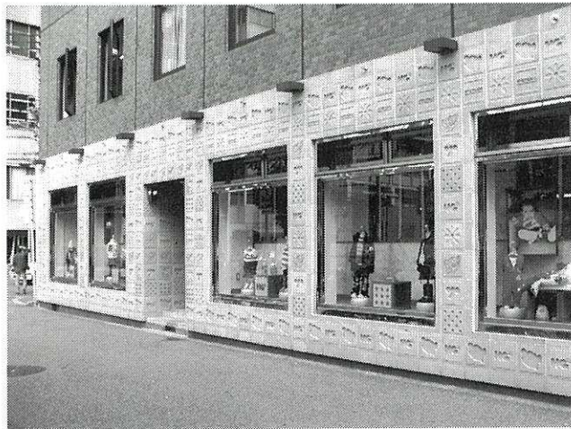
写真9 事務所ビルの1階を改造した店
