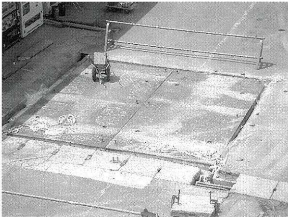
写真-2 ポーラスPC版の敷設状況
