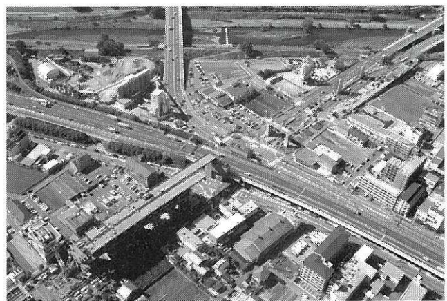
写真-11 名神高速道路上付近の送出し架設状況 (大阪建設工業新聞社提供：H16.9撮影)
