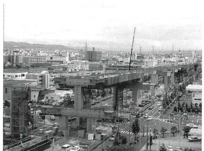
写真-8 桁脚剛結部を含む高架構造の建設状況
