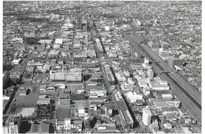
写真－2 大手筋通付近より北を望む (大阪建設工業新聞社提供：H16.9撮影)
