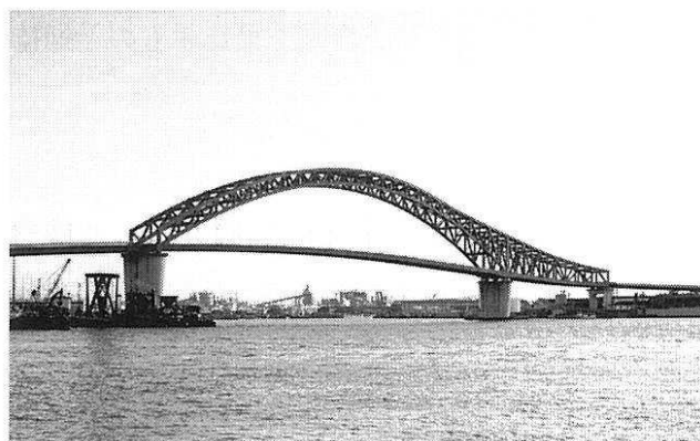
写真1 千歳橋の全景
