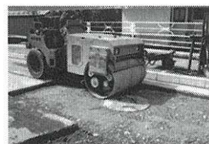
写真-4 舗装本復旧状況
