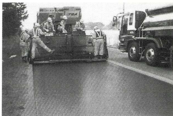
写真二 敷きならし状況
