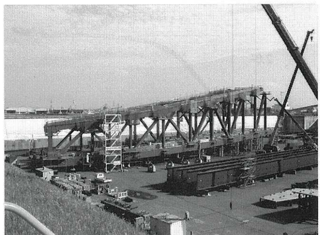
写真3 トラス部地組立状況
