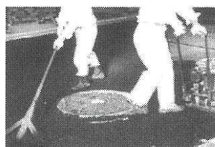
写真-2 マンホール蓋周辺転圧
