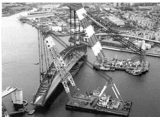
写真6 アーチ部ブロックの一括架設
