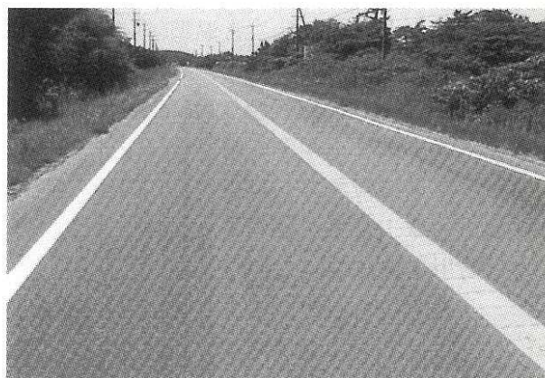
写真三 施工10ヶ月後の状況
