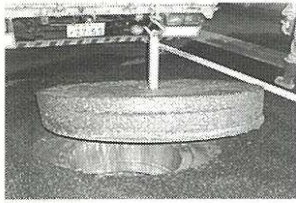
写真-6 アスファルト躯体撤去
