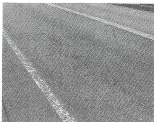
写真一 施工前
