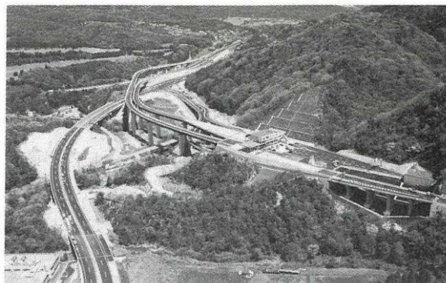
写真－4 西宮山口JCT、西宮山口東出入路付近
