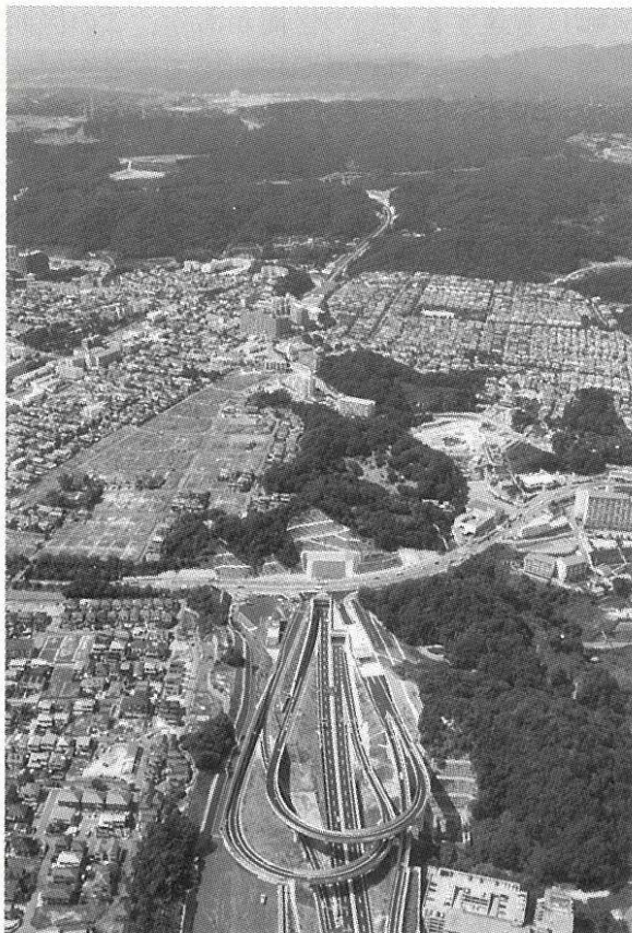
写真一 6 白川南出入路、白川トンネル付近
