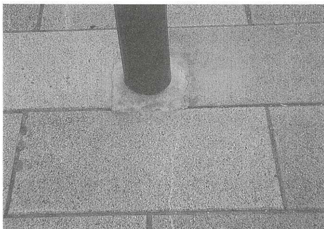
写真10：他工事での施工例
