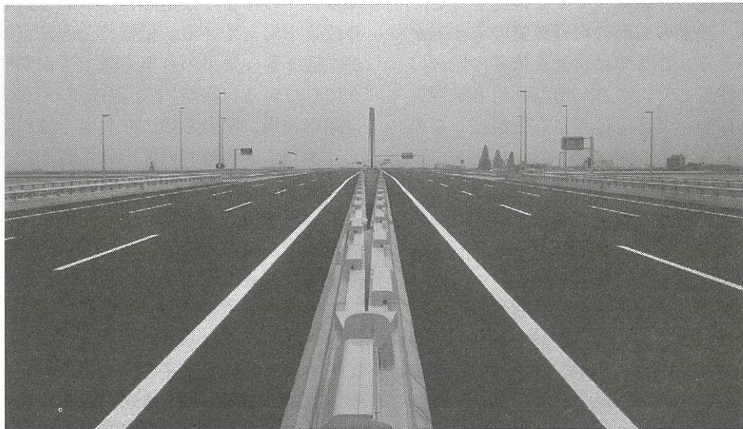
第二名神高速道路桑名舗装工事（揖斐川橋）より
