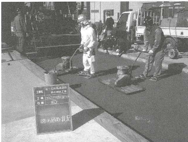
写真-5 締固め状況
