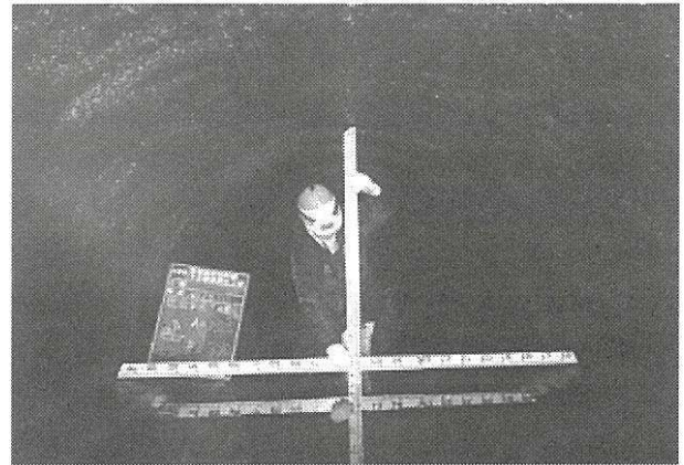
写真-1 既設内径寸法
