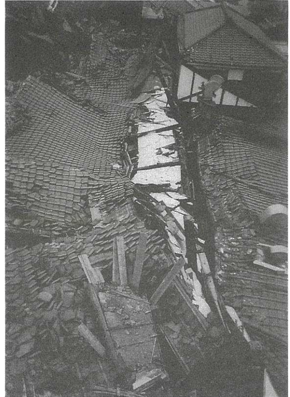
写真2：震災直後の付近の状況 (木造の酒蔵の多数が倒壊)
