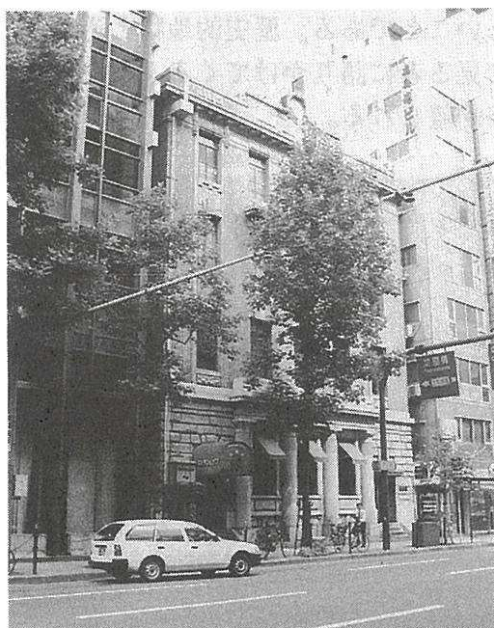
写真・15 良好な状態で維持されているビル（大阪市中央区）
