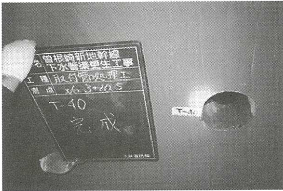
写真-6 取付管口仕上げ
