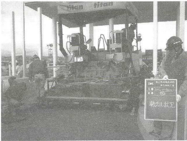
写真-4 敷均し状況
