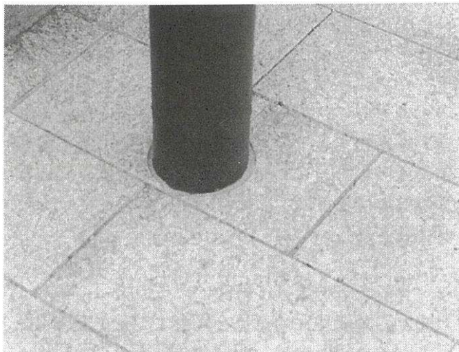
写真9：今回施工例（舗装平板と照明柱の間の隙間が目立たないように仕上げた）
