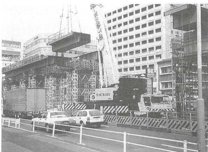
写真7 トラッククレーンベント架設
