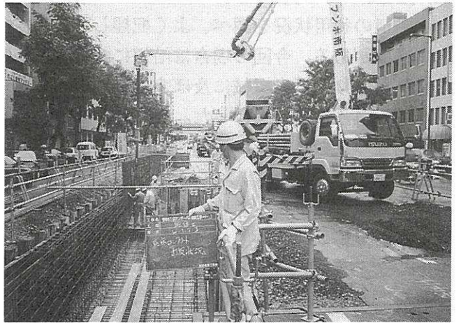
工事中 道路占用帯内作業
