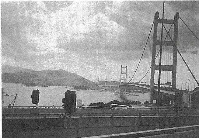
写真-3 道路と鉄道の併用吊橋の青馬大橋
