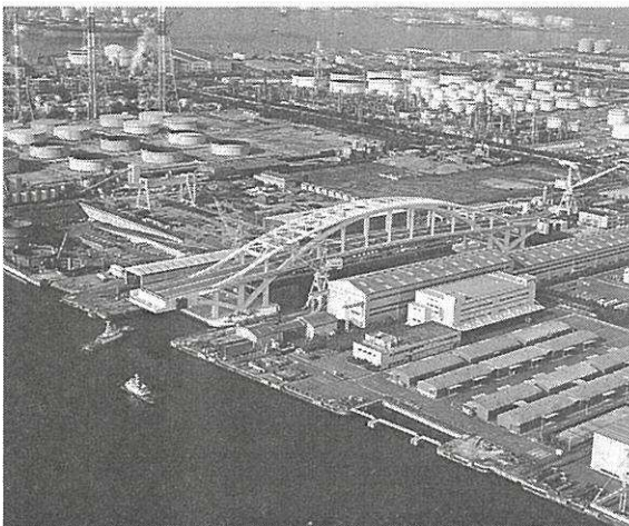
写真-6 浮体橋の出渠
