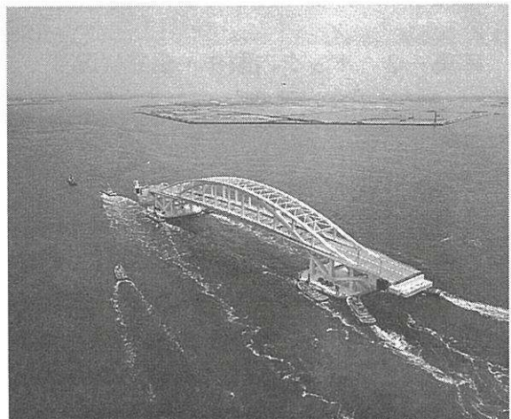
写真-7 浮体橋の海上曳航
