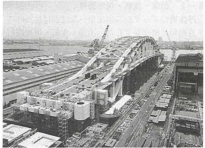
写真-4 ドック内製作・組立状況
