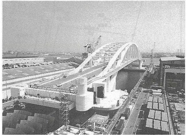
写真-5 ドック内製作・組立状況
