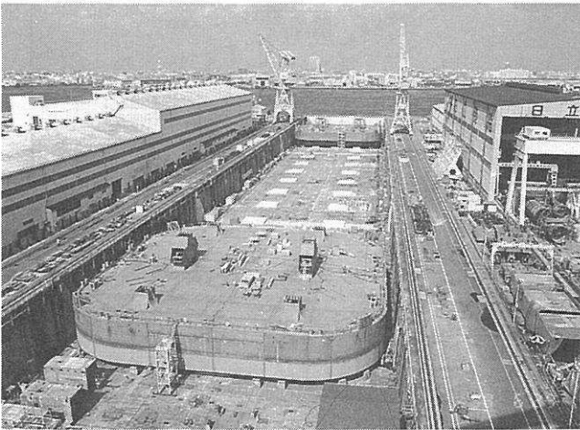
写真-2 ドック内製作・組立状況
