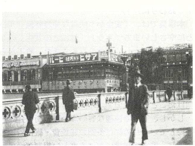
写真-6-2 高欄全景
