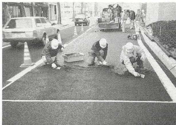
photo-6 表面処理 施工状況
