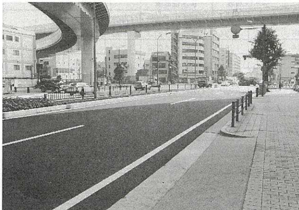
photo-9 排水性舗装 (I) 工区
