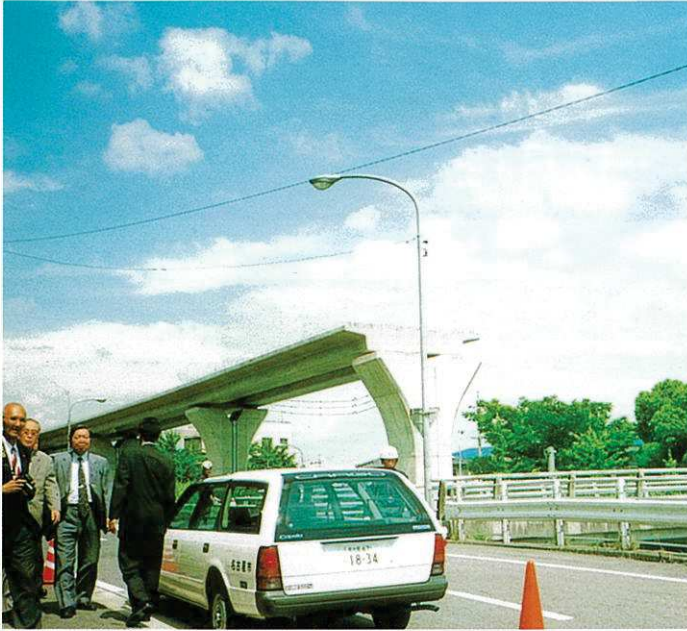
ガイドウェイバス工事現場
