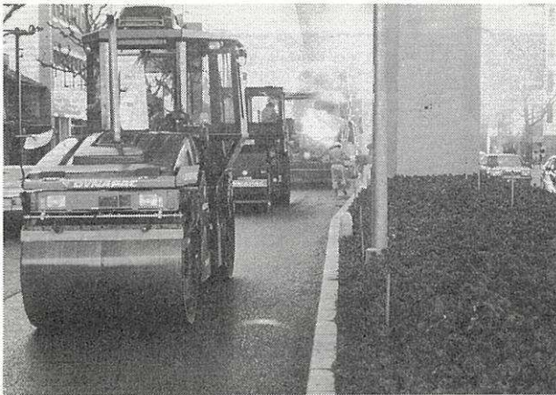
photo-3 タンデムローラによる二次転圧
