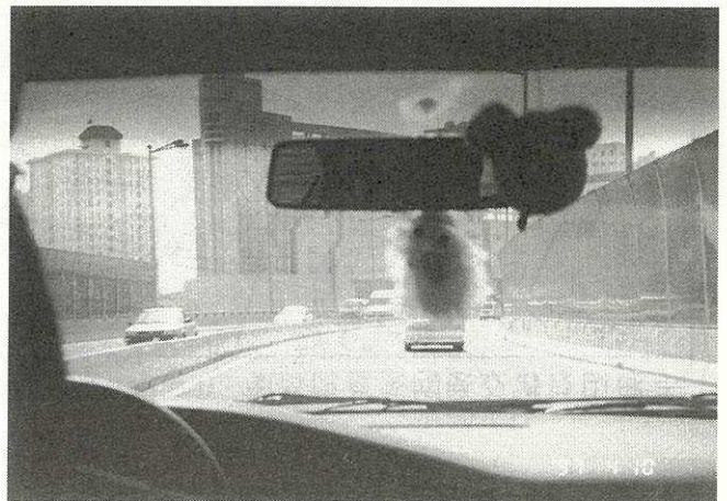
写真11 都心部の高架の高速道路 （部分的に透明の防音壁が設けられている）
