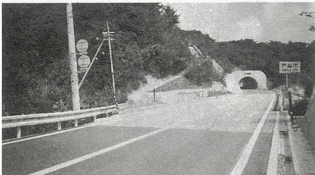
写真-4 バイパス完成写真
