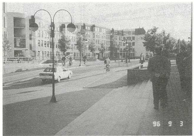
写真17 鉄道との緩勾配の立体交差
