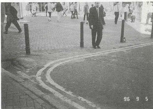
写真18 ショッピングモールの路面のかさ上げ
