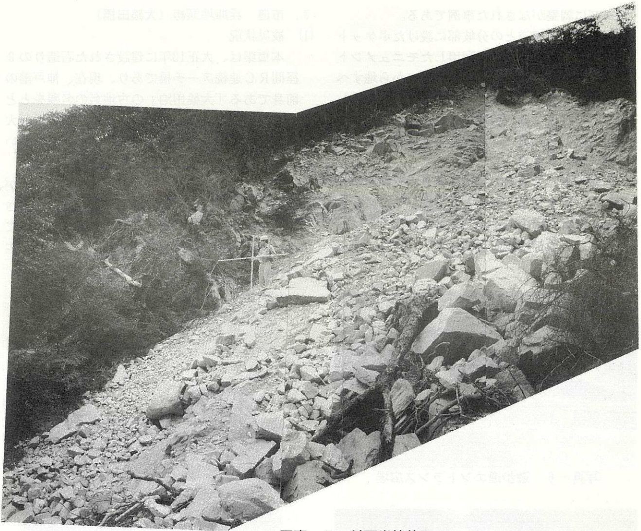
写真-3 斜面崩壊状況
