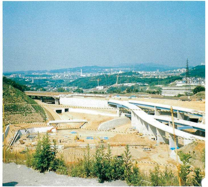
垂水ジャンクション工事現場
