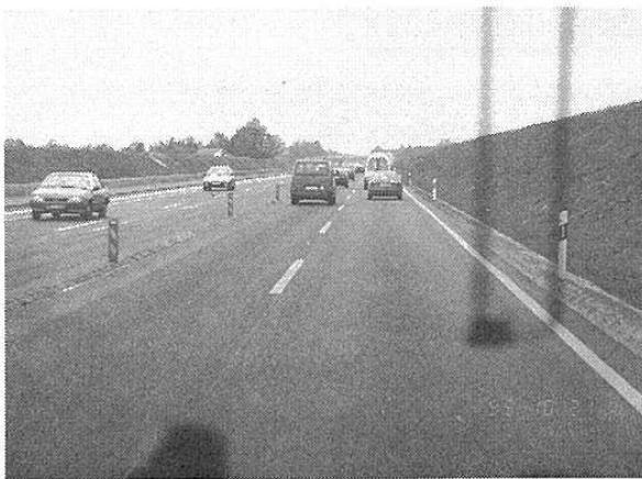
【写真-10】 アウトバーンの維持補修現場。本来は一方向三車線道路を黄色の車線区分線と簡単な板状の赤白のポールによる中央分離により往復四車線運用。日本では考えられない程簡単な安全対策。
