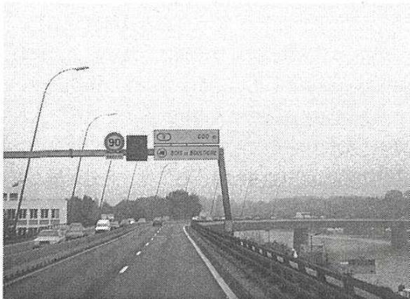
【写真-24】 パリのセーヌ川を渡る高速道路橋。道路照明灯は斜めポールにして軽快感を出している。船のマストの様にも見えセーヌ川の景観にマッチしたものとなっている。
