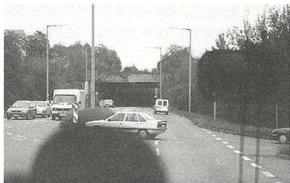
【写真-7】 Neugereut地区のトンネル。道路両側の中層住宅への騒音対策として人工的に蓋掛けをしたもの。これにより14dB(A)～22dB(A)の騒音減少が図られた。
