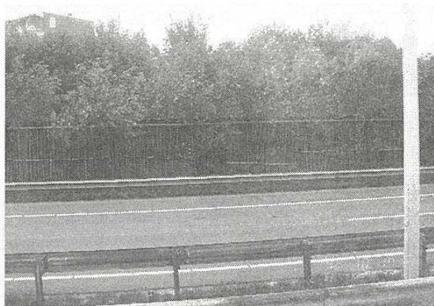
【写真-3】 アムステルダム市内高速道路の遮音壁。耐候性鋼板と柳の木を組み合わせたもの。メンテナンス費の安い耐候性鋼板と根付きがよく、成長の早い柳を植えて美観と防音効果の向上を図っている。
