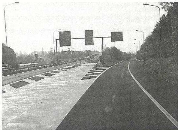
【写真-16】 スイスの高速道路で見かけた非舗装レーン。（中央車線の前方）長い下り坂のためブレーキ異常を起こした大型車がタイヤと地面の摩擦を利用して停車できるように配慮されている。
