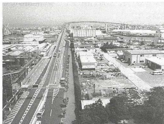
写真-6 (港区側より望む) 完成写真
