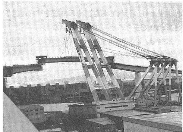
写真-4 主橋梁部の架設（STEP 5）
