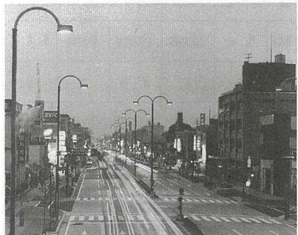
写真-4 統合柱による照明
