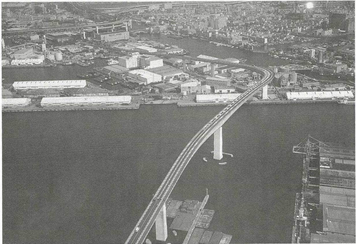
写真-1 なみはや大橋
