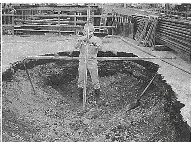
写真3 舗装を除去して空洞を確認
