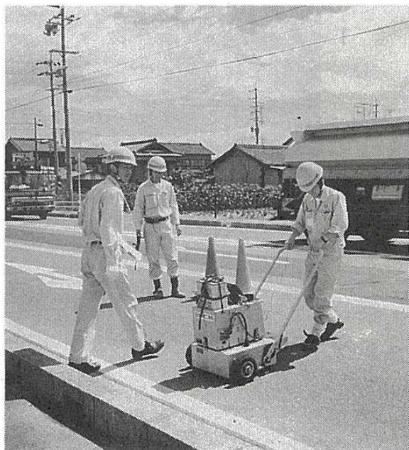
写真2 地中レーダーによる探査状況
