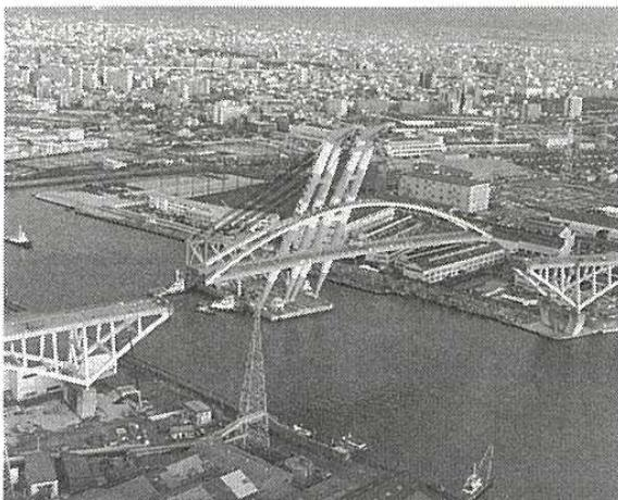
写真-3 中央径間部の架設
