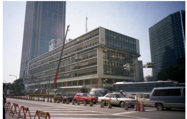
5階部分が座屈破壊した市役所2号館
