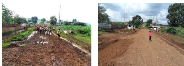
プロジェクトの成果、施工前と施工後
