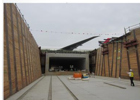
掘削深度10m迄:鋼矢板・親杭横矢板
