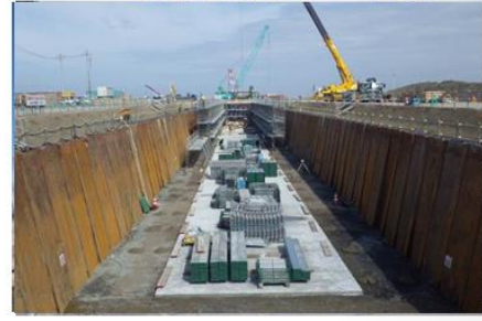
掘削深度5m迄:セメント改良地盤(B1m、D6~8m) 親杭横矢板(5×20鉄板)
