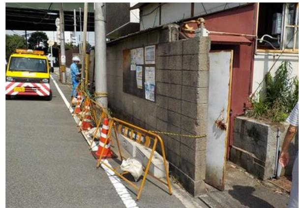
写真-3 ブロック塀緊急措置
