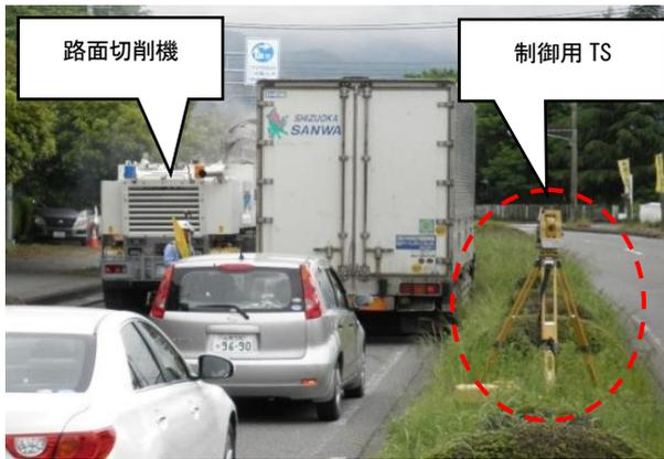
写真-1 修繕工事での MC 適用状況
