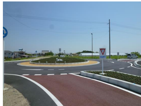
写真-1 本格運用の状況
