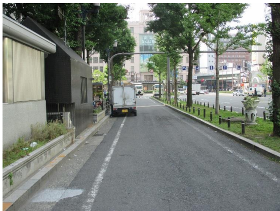
写真-2 整備前の側道車線
