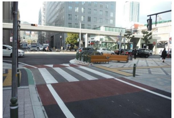
写真-8 スムース横断歩道
