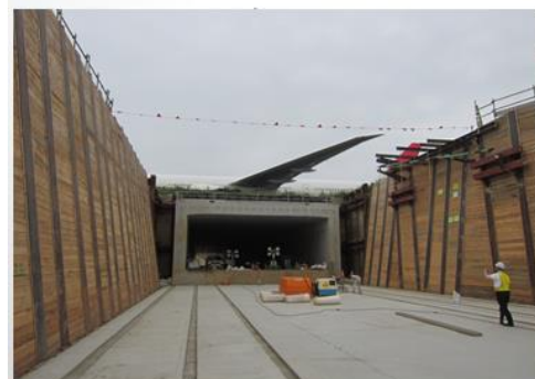
掘削深度10m迄:鋼矢板-親杭横矢板
