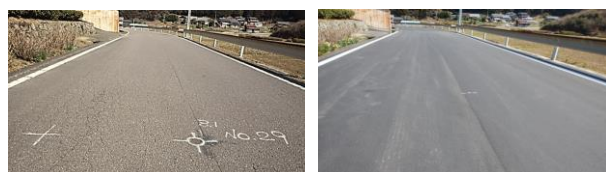
写真-1 施工前後の状況写真
