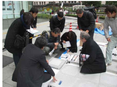
写真-3 舗装材の試験張り風景
