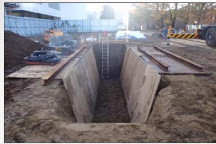
掘削深度2.5m迄:鉄板
