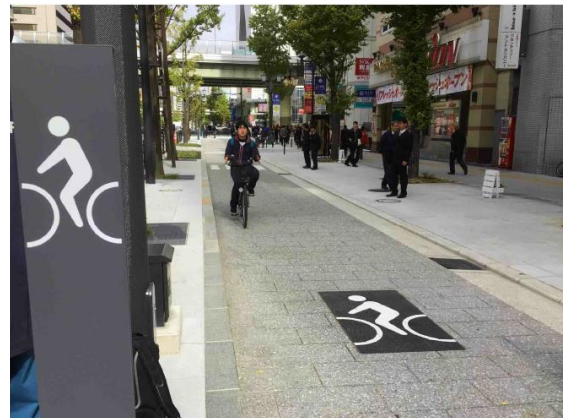
写真-6 供用開始後の現場写真
