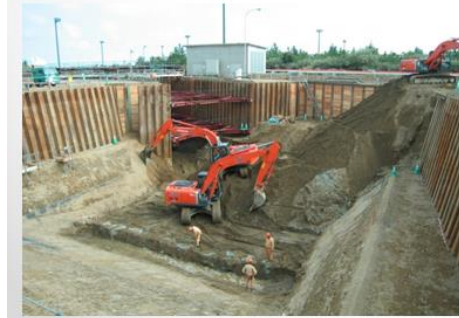
掘削深度10m迄:鋼矢板-親杭横矢板
