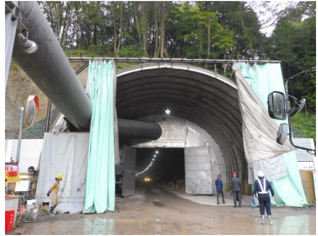
トンネル入口
