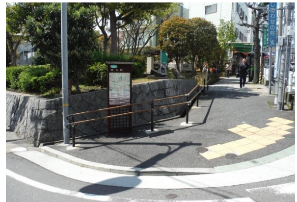
写真-10 利用者への配慮（手すりの設置）
