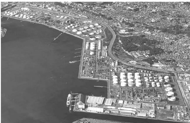
図2 製油所の例 (JX エネルギー(株) 根岸製油所) (写真 Google Inc.)
