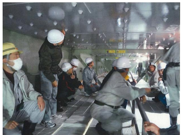
吊足場の上で鋼板接着工事を見学
