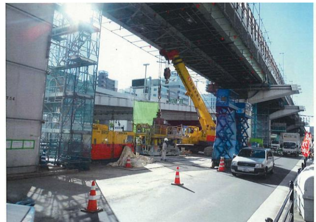
大規模な交通規制による高架橋の拡幅工事
