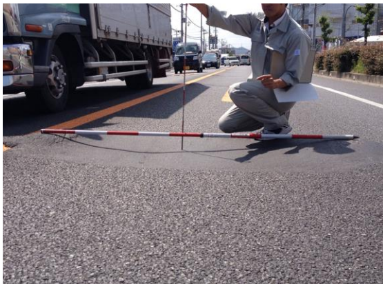
写真-2 わだち掘れ状況
