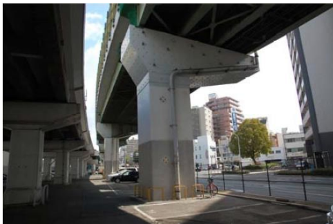
図-13 橋脚 B の外観
