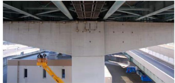
図-14 橋脚 A の外観
