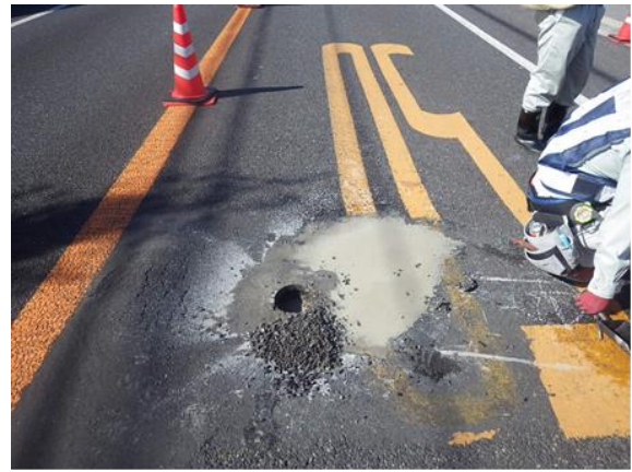
写真-3 舗装抜き取り調査
