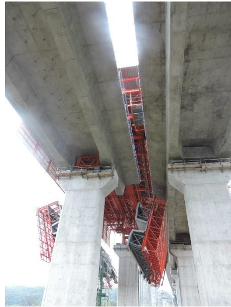
移動支保工から1スパン分の型枠が吊り下げられている。
