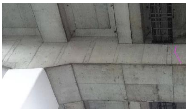
図-28 橋脚 D2 のひび割れ状況
