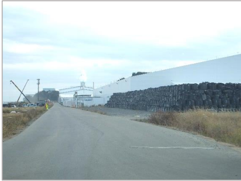
写真－2 富岡駅附近の除染処理施設と黒い袋の除染物
