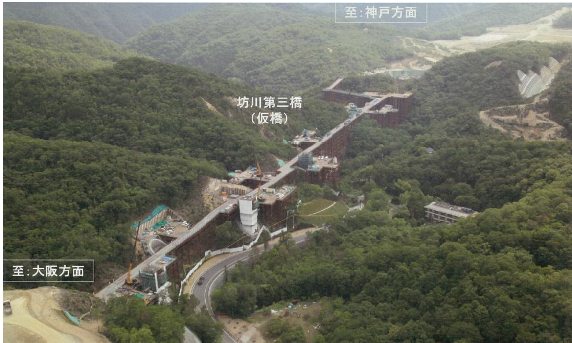
坊川第3橋工事現場俯瞰写真(新名神兵庫事務所資料より)
