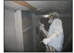
鋼桁の重防食塗装 (フッ素樹脂塗装)
