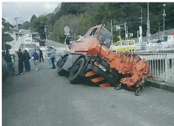
写真-3 垂水区での陥没事故
