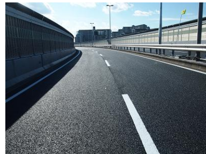
写真-2 舗装補修の施工状況（施工後）
