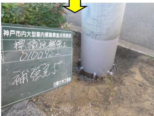
写真-2 炭素繊維シートによる補強
