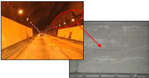
トンネル覆工コンクリートのひび割れ
