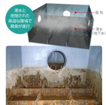
図-13 鋼製基礎(フーチング)内部損傷状況
