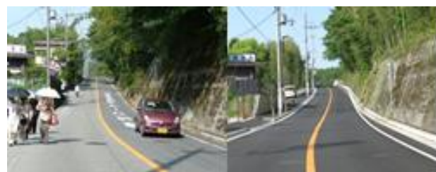
現道拡幅部の施工前と施工後
