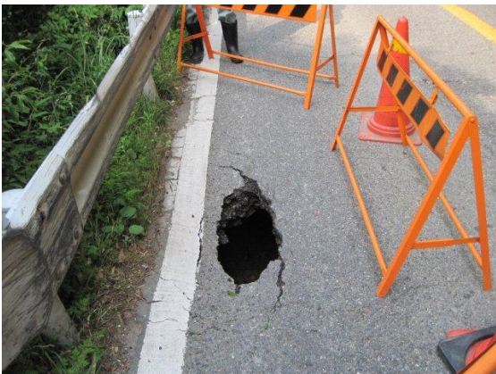
写真－５ 北区での路面陥没
