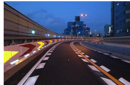
写真-3 安全対策の施工状況（施工後）
