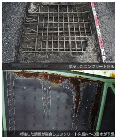
図-15 コンクリート床版の損傷状況
