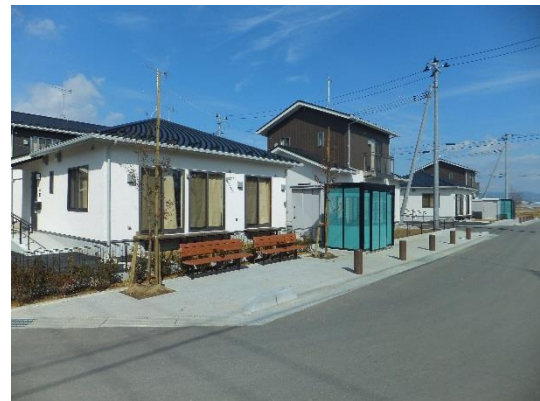
写真一 東松島市(あおい地区)の災害公営住宅
