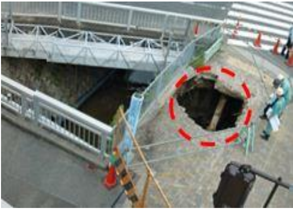
写真－４ 灘区での陥没事故
