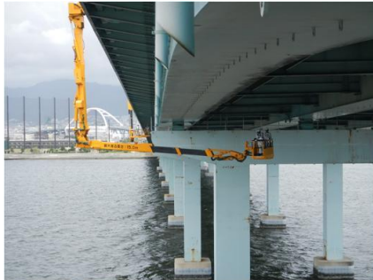
写真-1 橋梁定期点検実施状況
