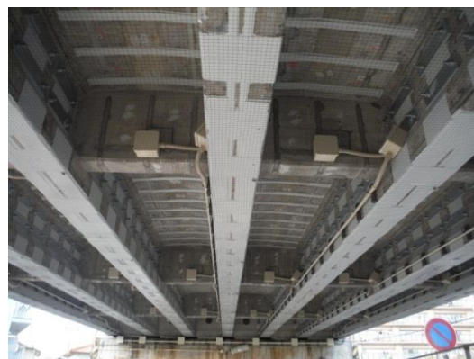
吉見跨線橋現場(主桁床版補修状況)
