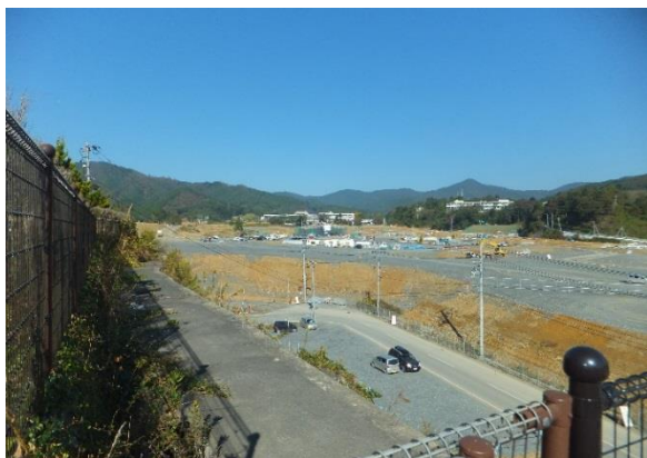
写真－1 造成工事と整備が始まった女川町中心部
