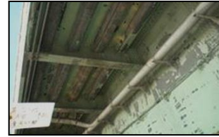
塩害による鋼桁の 塗装はく離
