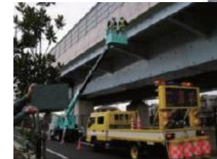
高所作業車による橋梁点検
