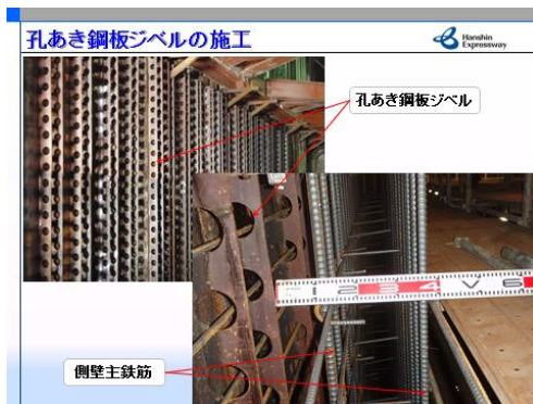
穴あき鋼板ジベルと側壁鉄筋の組み上がり
