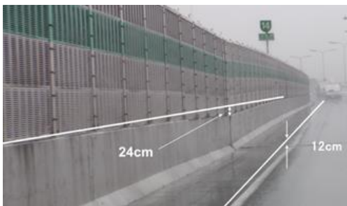
図-9 喜連瓜破付近の路面状況
