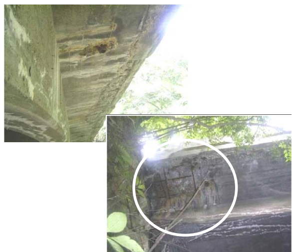
写真-1 老朽化した橋梁(昭和31年建設)
