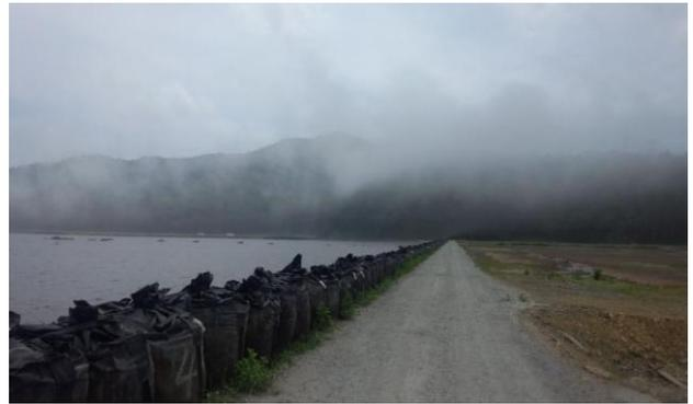
写真-6 工事用道路兼用仮締切り
