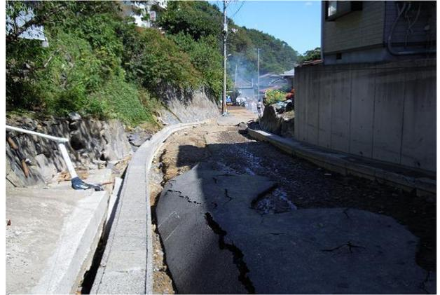
写真-12 鉄砲水による道路舗装のめくれ
