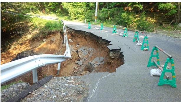
写真-11 アクセス道路の被害
