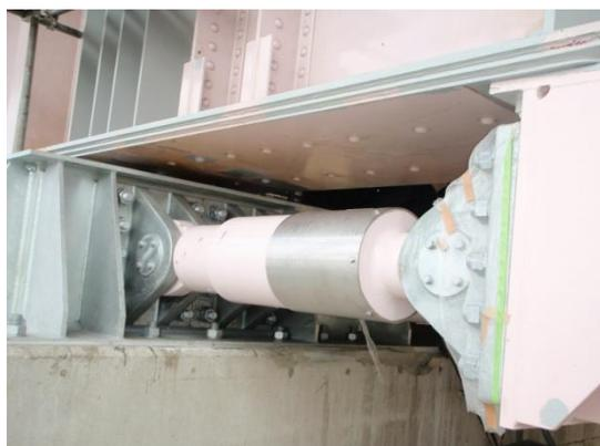
写真-7 摩擦履歴型ダンパー
