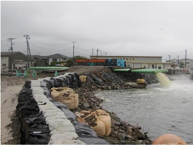
写真-10 仮設ポンプによる強制排水
