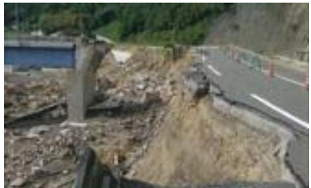
写真-2 護岸崩壊(橋台背面が崩壊)
