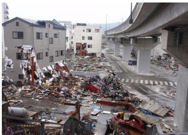
写真6 耐震補強された高架橋と被災している家屋
