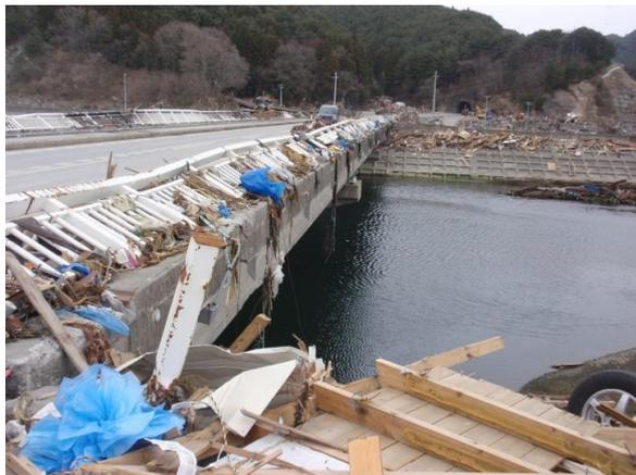
写真5 高欄の倒壊
