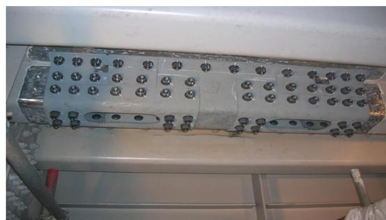
写真4 Uリブ取替工法
