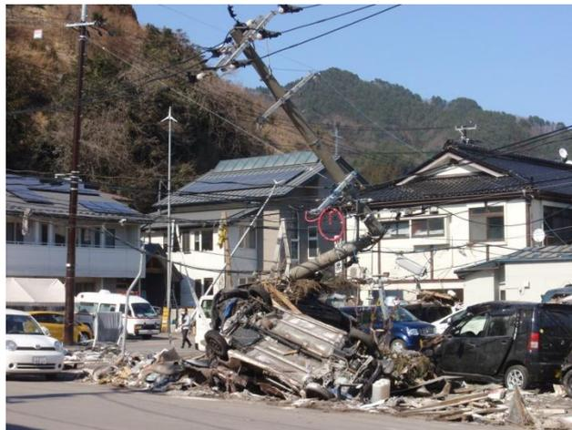
写真8 電柱の倒壊
