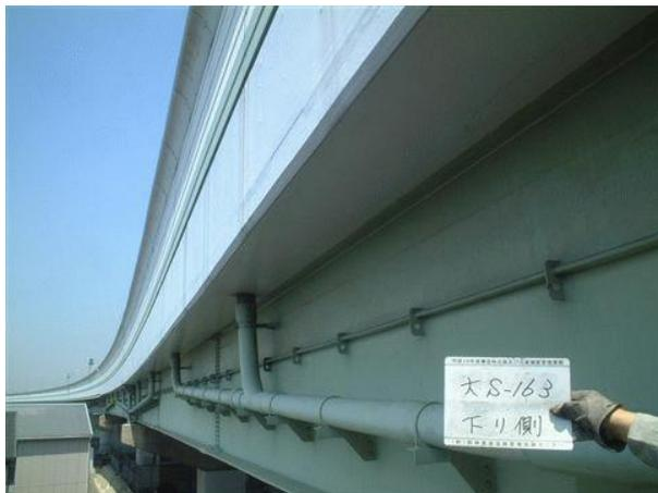
写真7 高欄点検状況（ガラスクロスによる補修区間）
