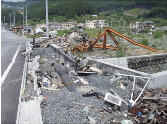
津波による洗堀で埋設管路が露出している
