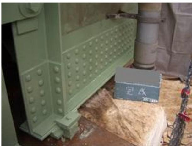
写真1 主桁端部の腐食補修
