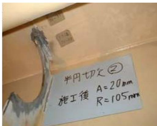
写真5 垂直補剛材に設置した半円孔
