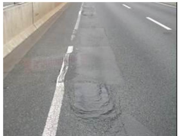
写真8 グースの損傷の一例
