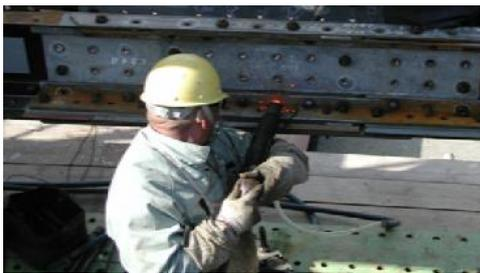
写真-2 リベット継手施工風景
