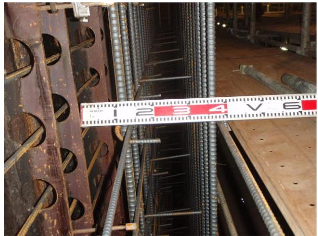
写真-1 孔あき鋼板ジベルと側壁鉄筋の状況
