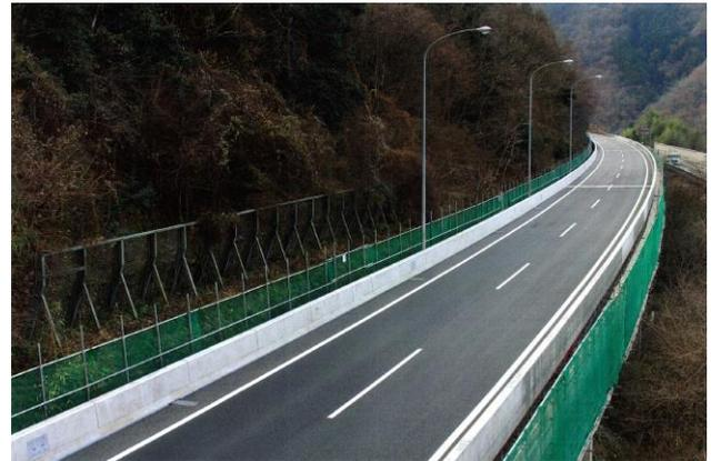
写真-12 橋面防水・舗装完了
