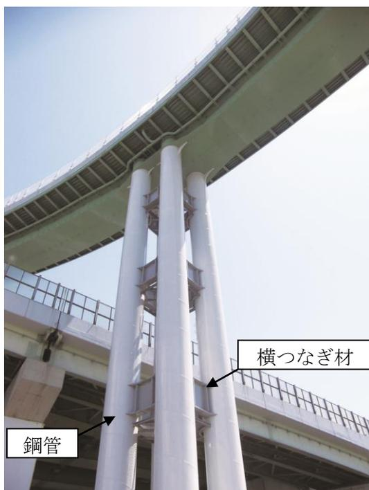
写真-3 鋼管集成橋脚
