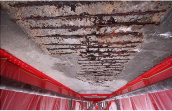
写真-3 床版下面の劣化（かぶり剥落）
