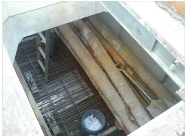
写真-3 特殊柵(既設管抱込み・底板後打ち柵)
