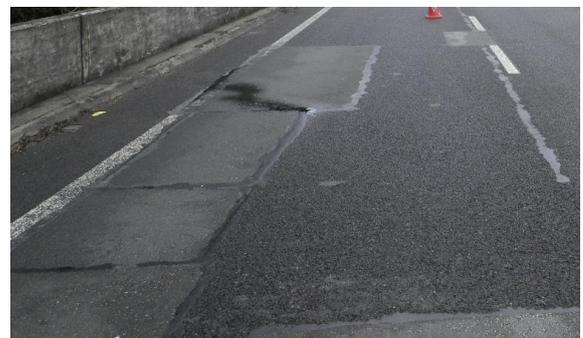
写真-1 アスファルト舗装の部分補修
