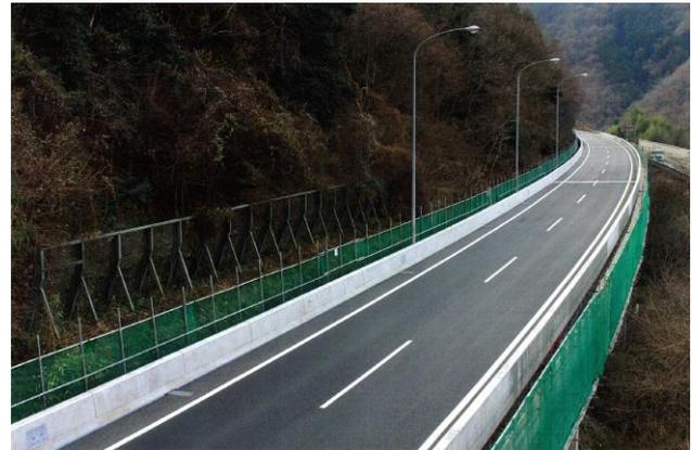
写真-12 橋面防水・舗装完了
