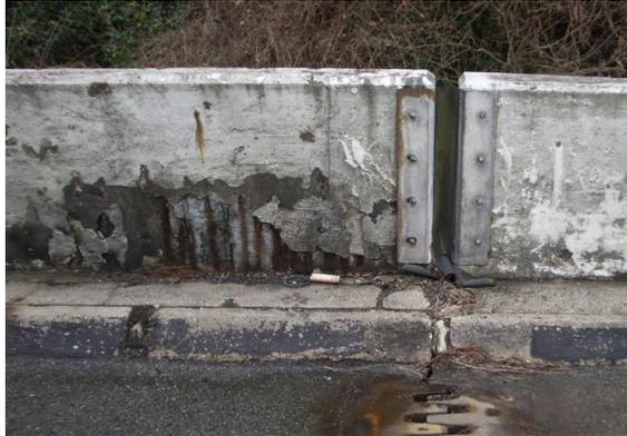
写真-4 壁高欄の劣化状況
