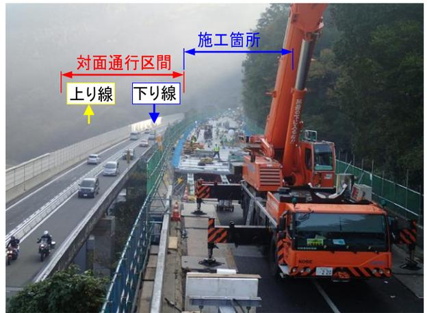
写真-6 対面通行規制下での施工状況
