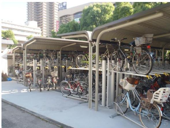
写真 - 3 上屋改築・垂直式2段ラックの導入
