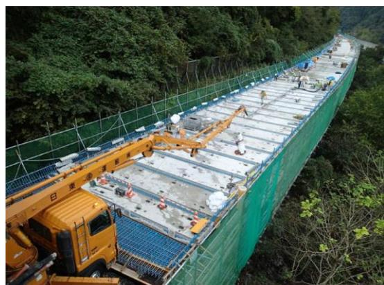
写真-11 間詰め場所打ちコンクリート打設
