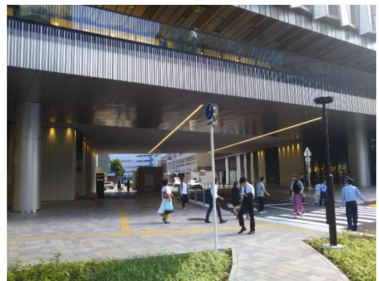
図-6 現況写真（道路上空部分）
